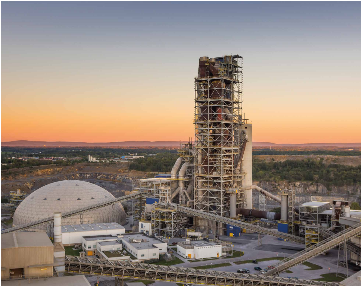
Martinsburg Plant, USA Region
