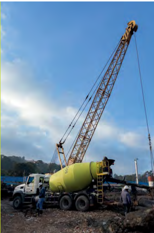
↑ Camión mezclador en obra en Bogotá, Colombia
