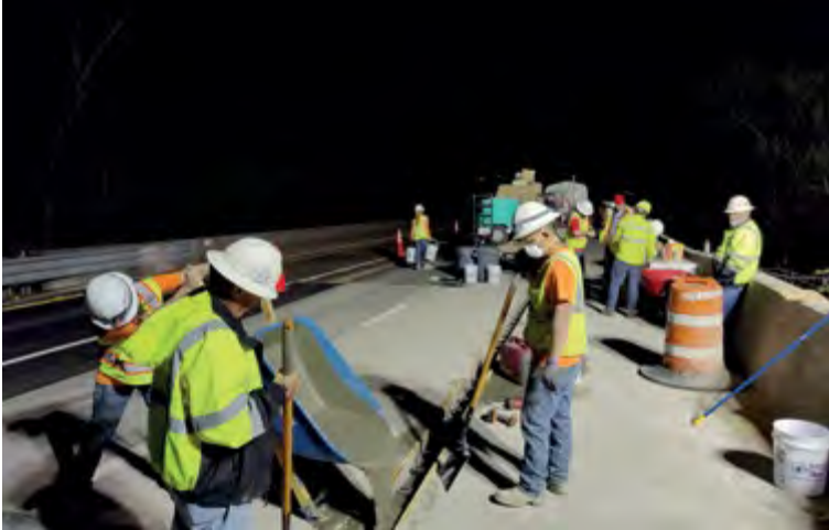
↑ Construcción con concreto UHPC, Estados Unidos
