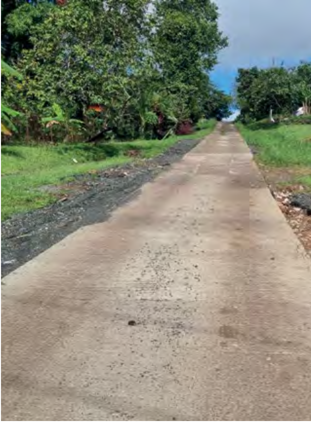
↑ Obra con ecomaterial, en el distrito de Arraiján, Panamá
