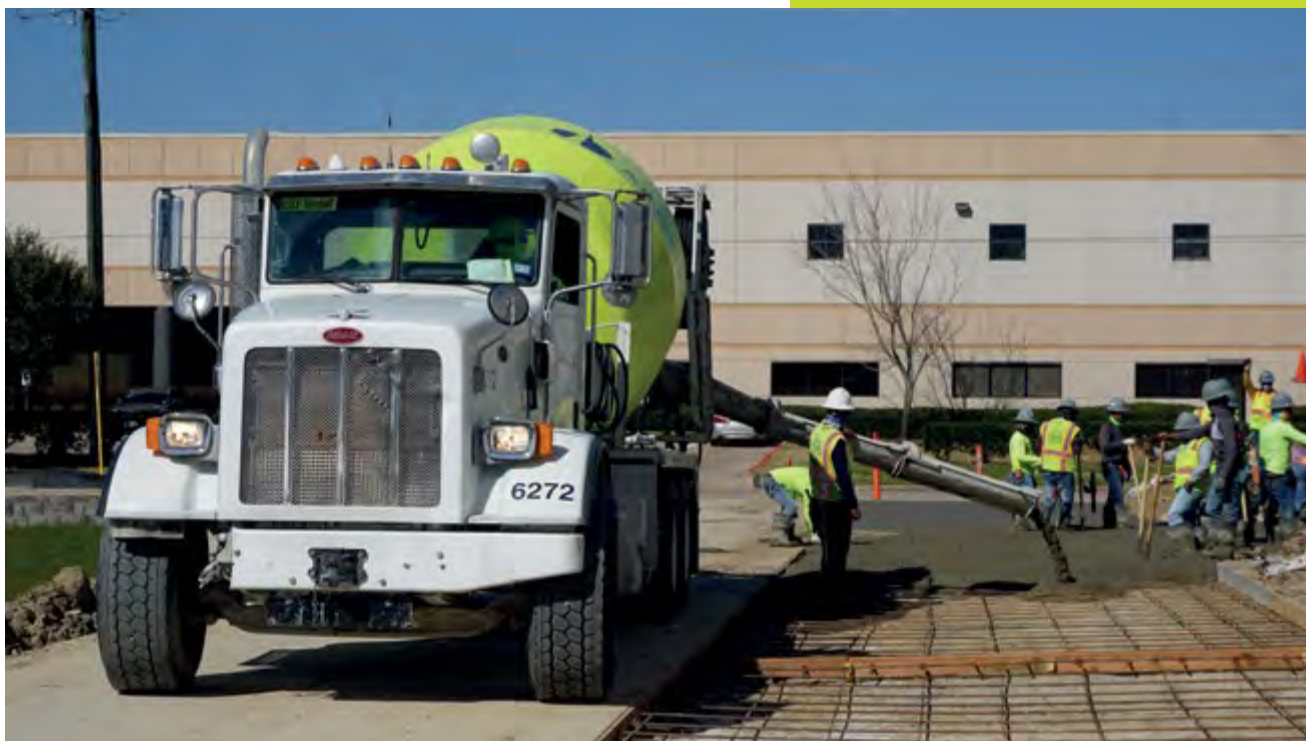
↑ Vaciado de concreto en Houston, Estados Unidos
