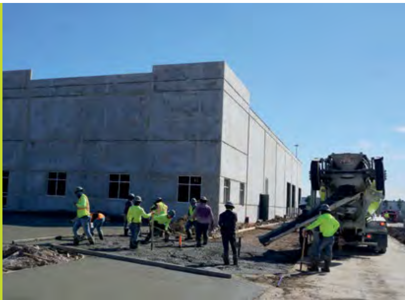
↑ Proyecto de vaciado de concreto en Estados Unidos
