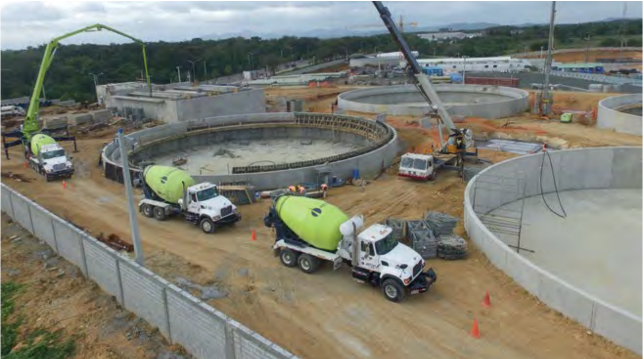
↑ Camiones mezcladores en obra, República Dominicana
