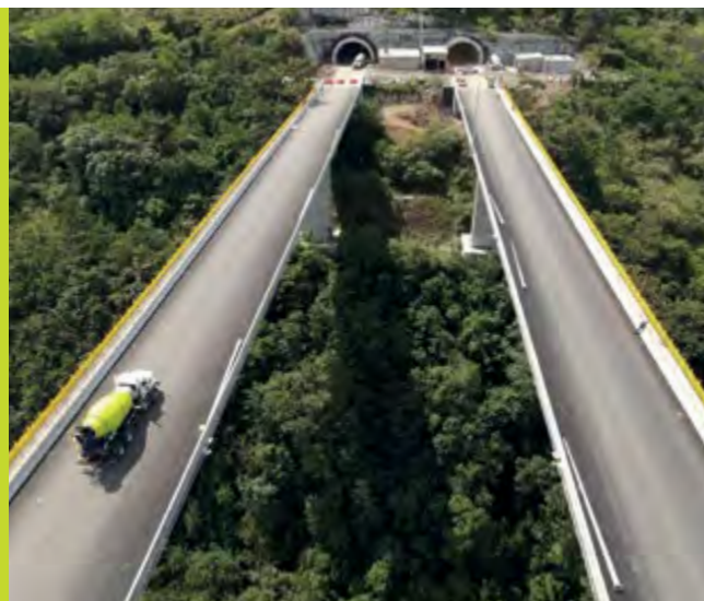
↑ Megaobra 4G de conexión Pacífico 2, suroccidente de Colombia
