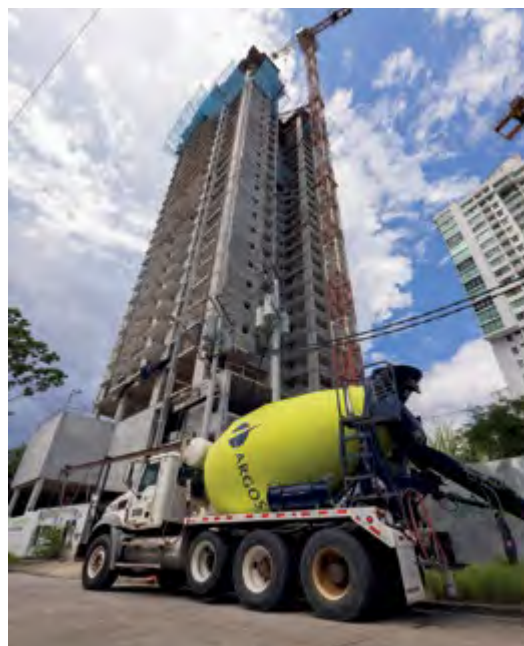
↑ Camión mezclador en obra, Panamá
