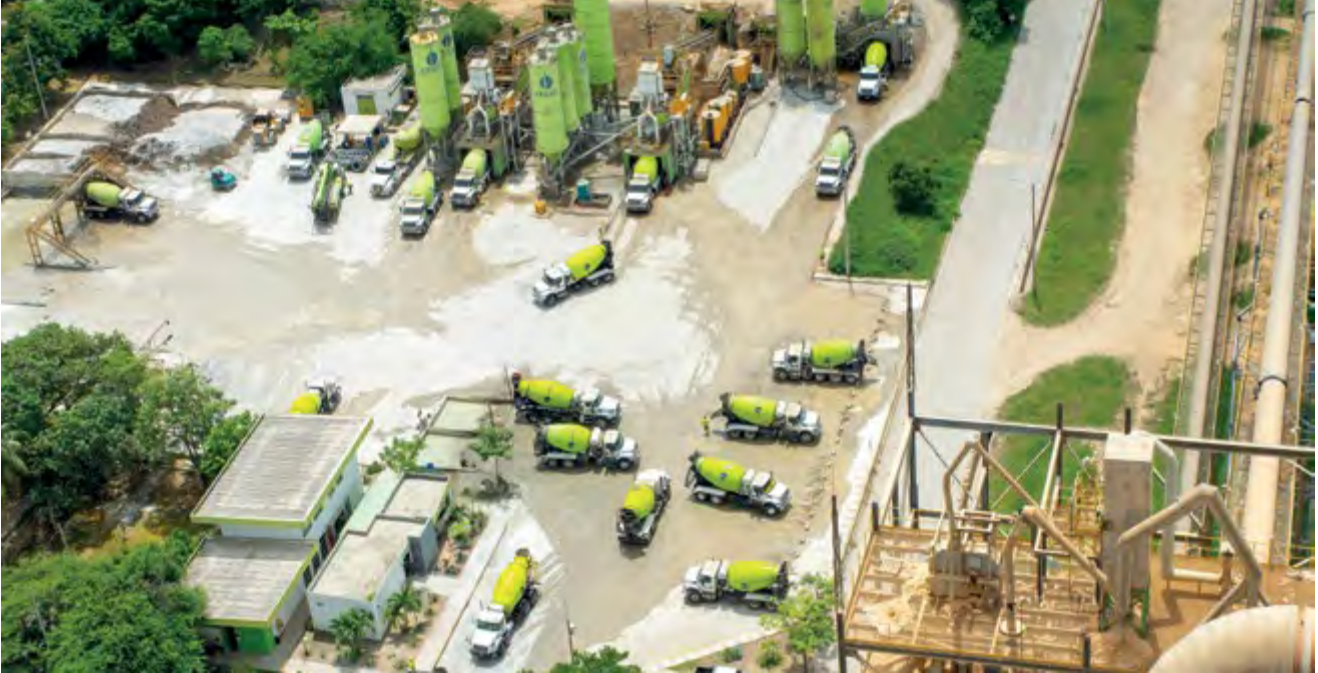
↑ Planta de concreto en Cartagena, Colombia
