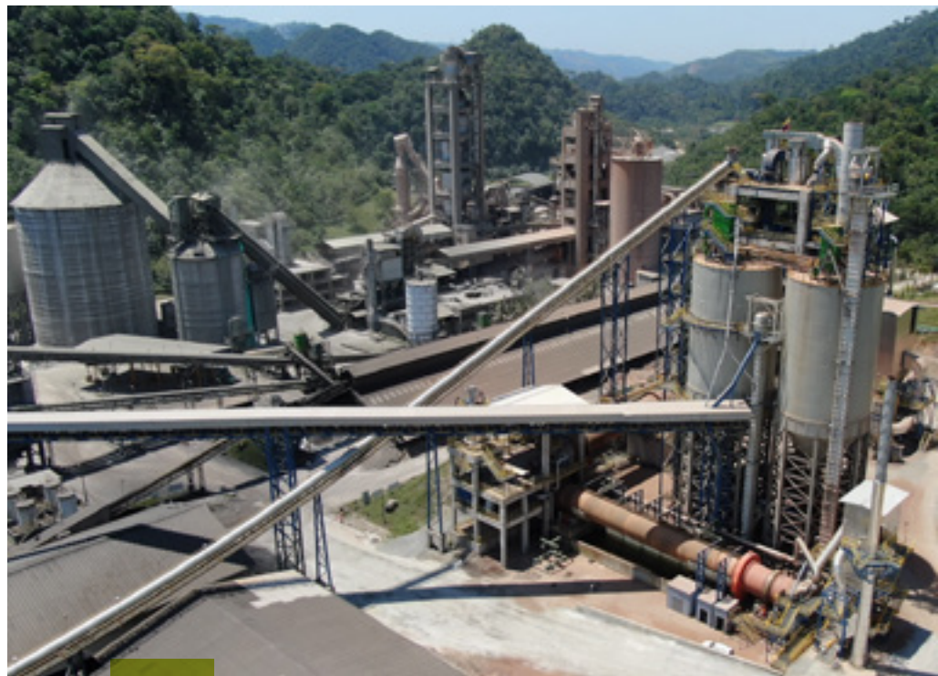
Nueva línea de activación térmica de arcillas. Planta Rioclaro, Regional Colombia
