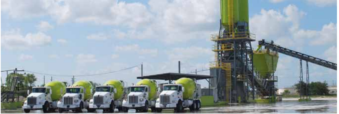
Planta de concreto en Houston Texas
