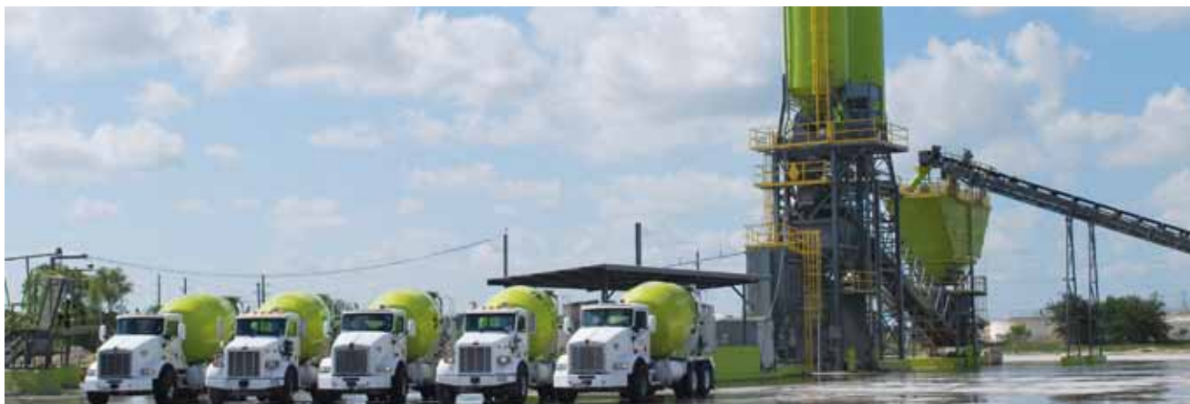
Planta de concreto en Houston Texas
