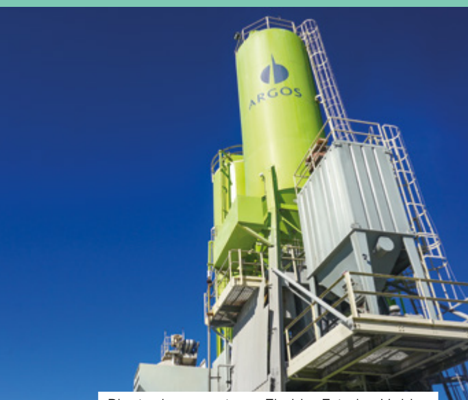
Planta de concreto en Florida, Estados Unidos
