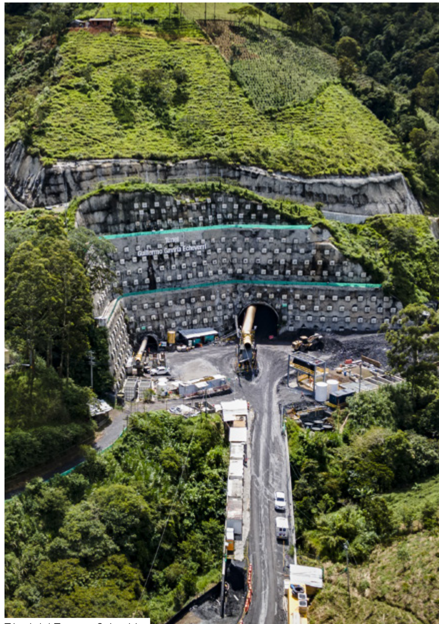
Túnel del Toyo en Colombia
