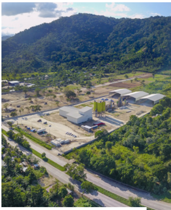
Estación de molienda Río Blanquito en Honduras
