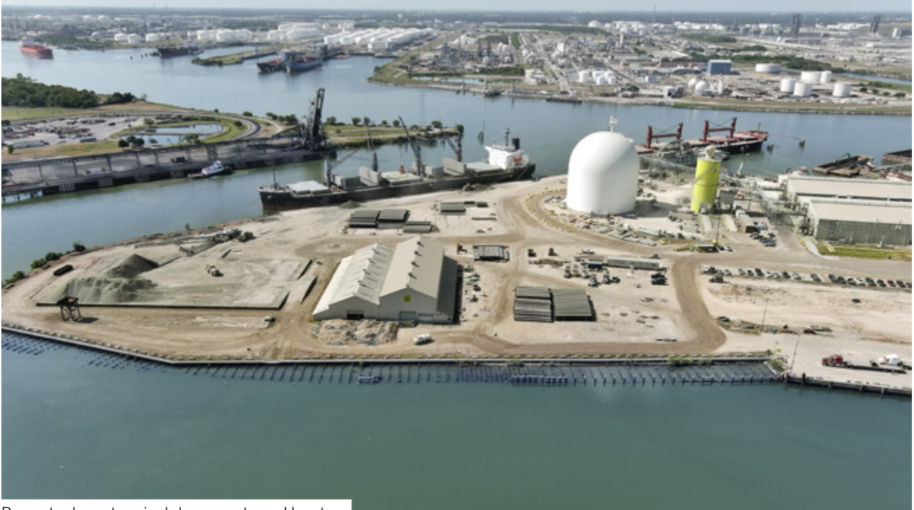
Proyecto domo terminal de cemento en Houston
