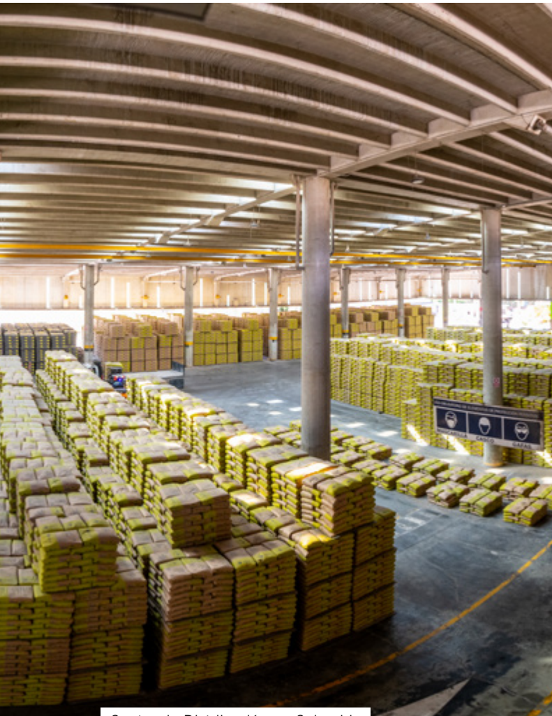
Centro de Distribución en Colombia
