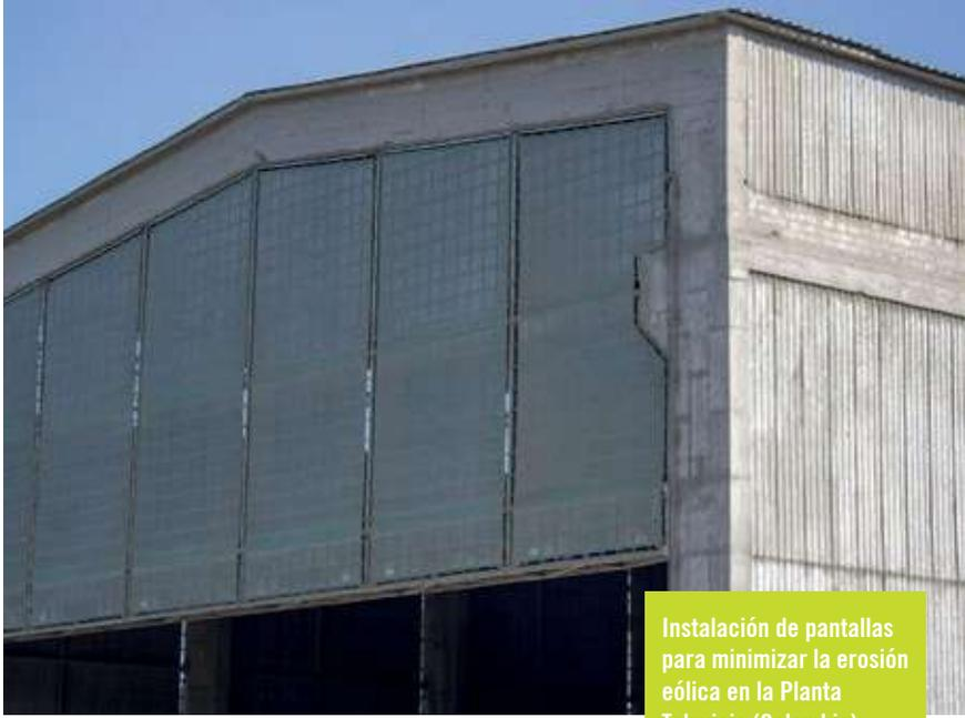
Instalación de pantallas para minimizar la erosión eólica en la Planta Toluvejo (Colombia)
