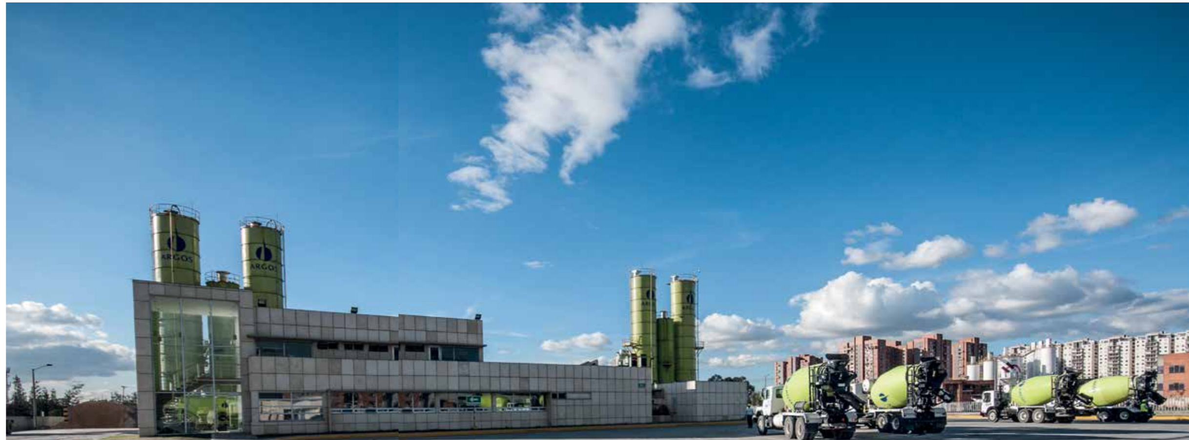
Puente Aranda Plant, Colombia
