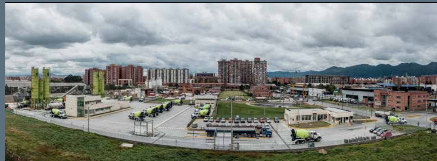
Puente Aranda Plant, Colombia
