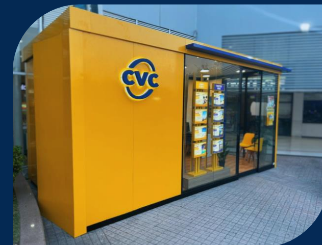
Modular Store - Assaí Anchieta São Bernardo do Campo - SP
