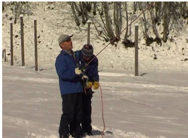
Retter gelangt von der Stütze aus über ein selbstbremsendes Seilfahrgerat zu den Fahrzeugen
