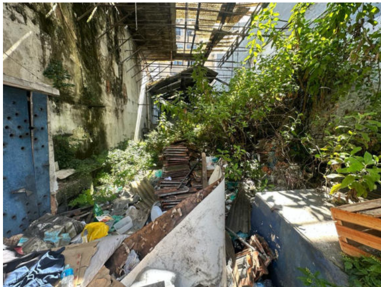
Foto 6: Visão geral do imóvel avaliando
