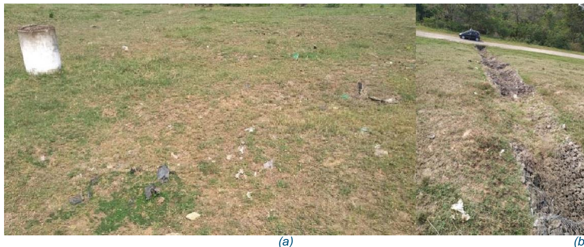
Figura 4 - (a) Evidências de afloramento de resíduos, com falha na cobertura (b) falha na manutenção do sistema de drenagem de águas pluviais.
