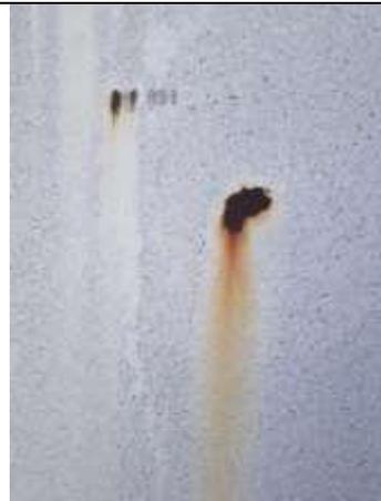
**Foto 125** – Pontos de corrosão no corpo dos elementos da torre.
