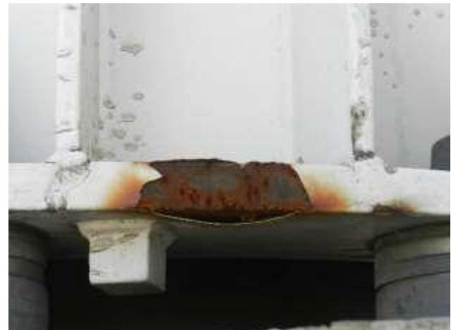
**Foto 121** – Foto ampliada da região com corrosão na base da torre.
