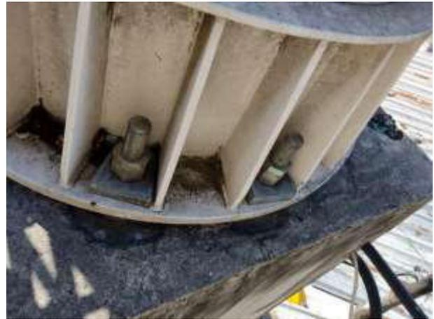
**Foto 123** – Junção entre a torre e a base de concreto apresentando acúmulo de detritos e corrosão.
