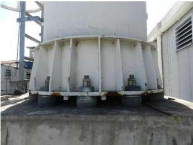
**Foto 120** – Conexão da torre e base de concreto apresentando regiões com corrosão.
