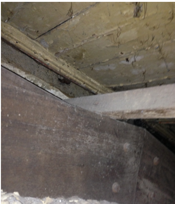
Forro em Gamela ainda com pintura e, em primeiro plano, estrutura em Cambota do forro em Estuque, na Nave
