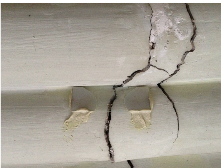
Vista de uma das fissuras e lamina de vidro (2x7cm) como testemunho
