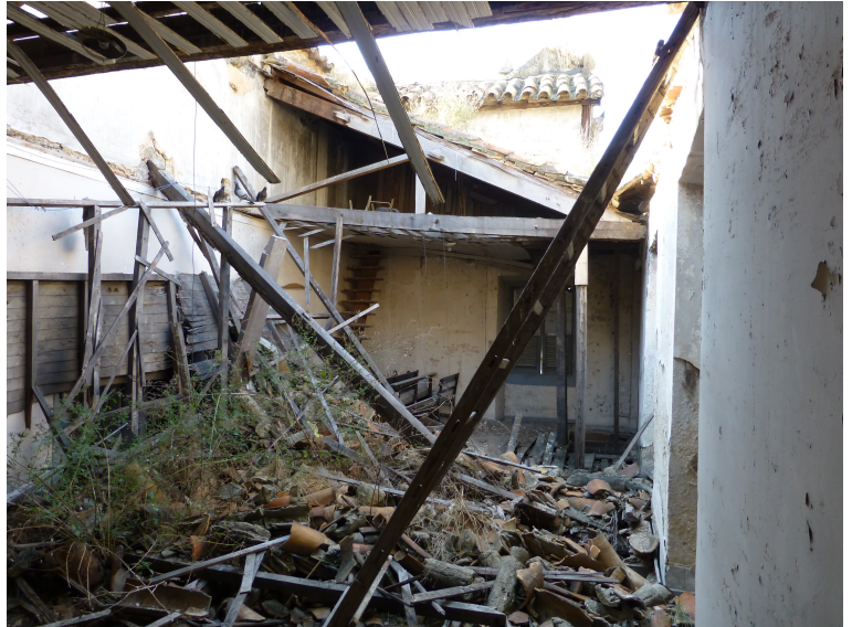
Salão antes da remoção do escombros da cobertura, ao fundo a meia tesoura deslocada
