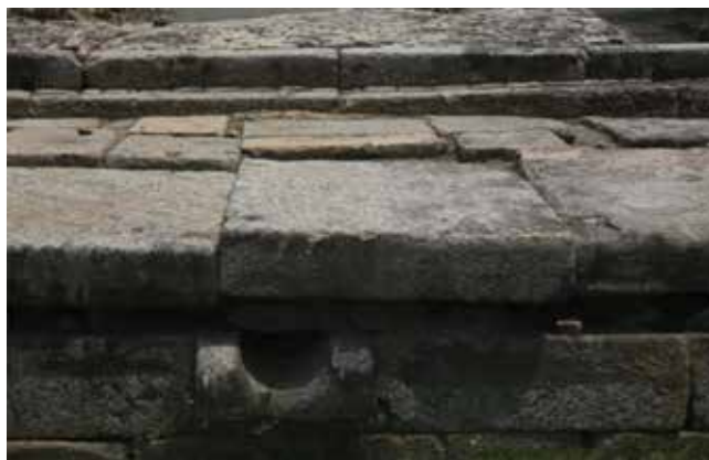
Foto 19 – Cais da Imperatriz. Bico para o escoamento de águas pluviais. Foto: João Maurício Bragança, 2014
