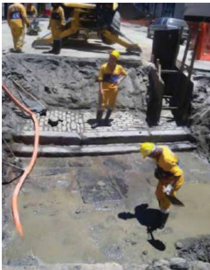
Figura 32. Costaneiras, degraus e piso de paralelepípedos evidenciados na frente 2.
