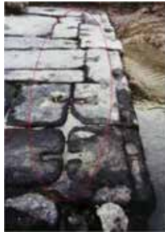
Foto 29 - Grampos ou âncoras usados para fixar as pedras. Fonte: ANDRADE LIMA
