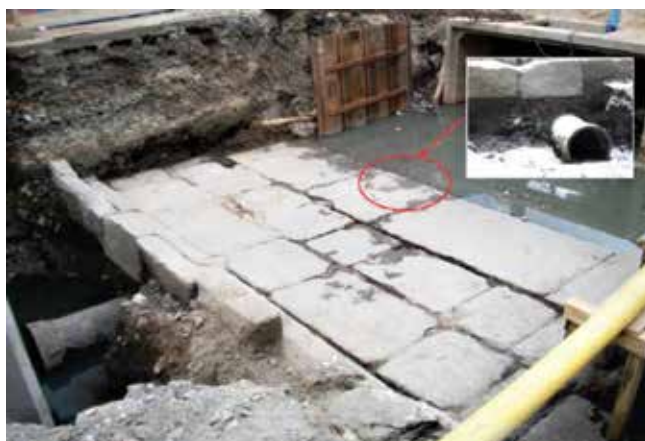
Foto 23 - Cano de ferro sob a estrutura. Fonte: Ibid., p.35
