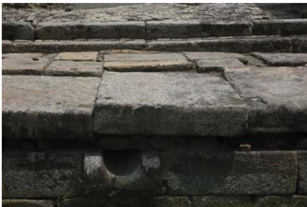
Figura 23. Cais da Imperatriz. Bica para desague das águas pluviais. Foto: João Mauricio Bragança ,2014.
