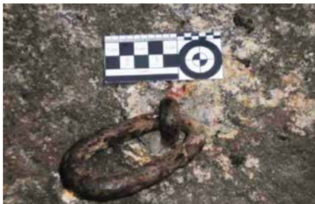
Foto 33 - Anel de amarração em metal ferroso exibindo a forma como foi anexado à rocha usando chumbo. Fonte: ANDRADE LIMA, 2013
