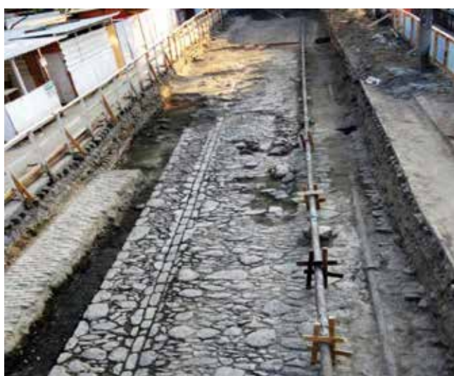
Foto 42 - Frente 4 – Pedras de pavimentação indicando a existência de uma calha. Fonte: Ibid., p. 69
