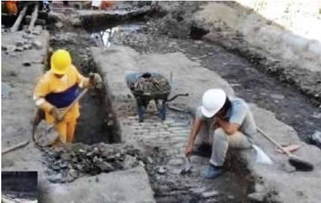
Foto 35: Piso de paralelos associado ao Cais da Imperatriz trecho oeste.
