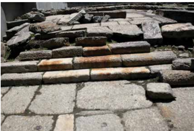
Figura 17. Cais da Imperatriz. As pedras costaneiras. Foto: João Maurício Bragança, 2014
