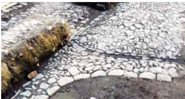
Foto 43 - Meio-fio e sarjeta descritos acima. Fonte: Idem, p. 70
