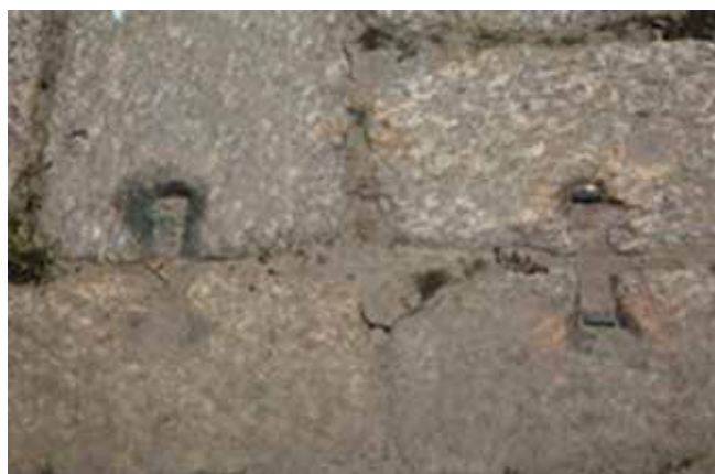
Foto 15 - Cais da Imperatriz. Detalhe de restos de grampos para prender as lajes. Foto: João Maurício Bragança, dezembro 2015
