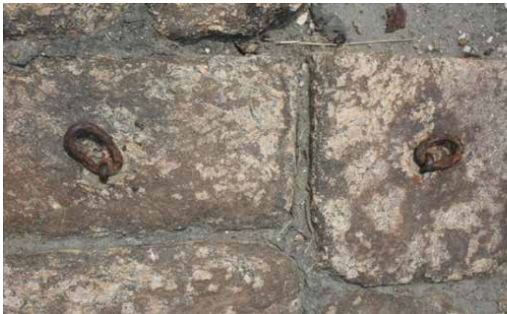
Figura 20. Cais da Imperatriz. Argolas de metal ferroso, que foram utilizadas para amarração.
