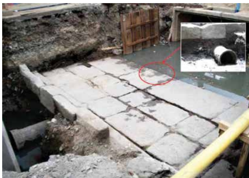
Foto 29: Cano de ferro abaixo da estrutura. Fonte: Ibid., p.35
