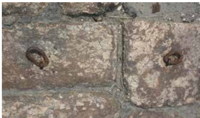
Foto 16 – Cais da Imperatriz. Detalhe de restos de grampos para prender as lajes. Foto: João Maurício Bragança, 2014
