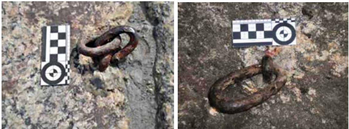
Figura 41 Arganéu de metal ferroso exposto à intempérie e fixado na proximidade da borda da cantaria.
