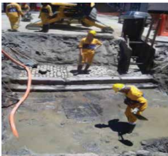
Foto 25 - Lajes, degraus e calçada pavimentada de paralelepípedos revelada na frente 2.
