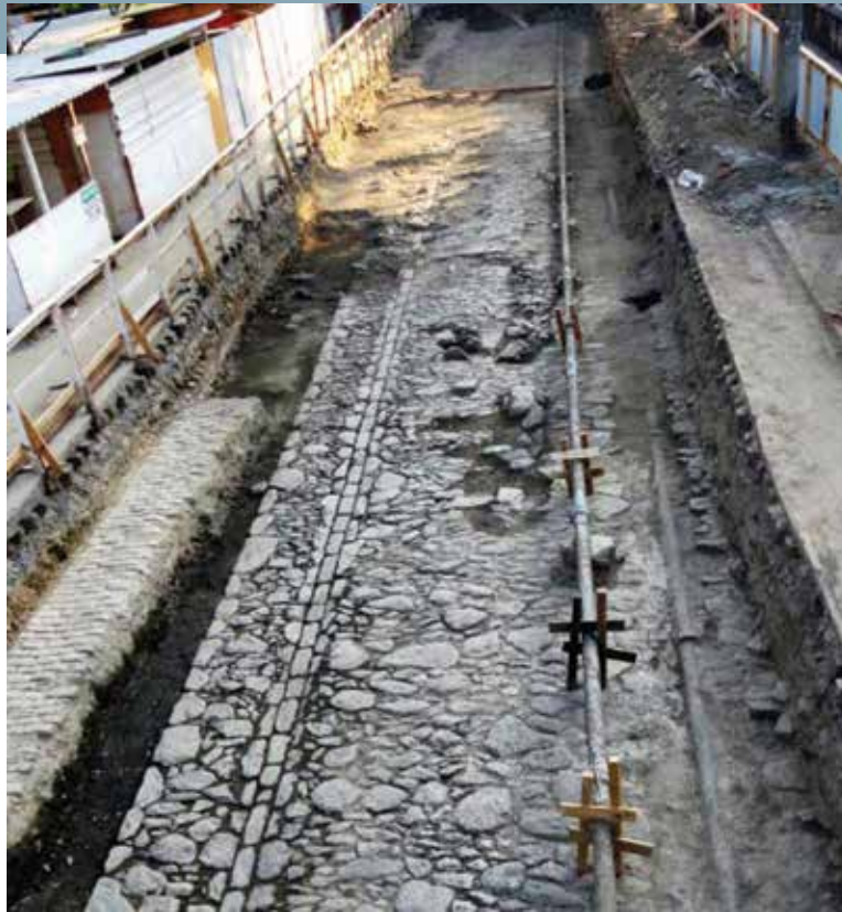
Figura 53. Frente 4 Calçamentos evidenciados e canaleta de drenagem.
