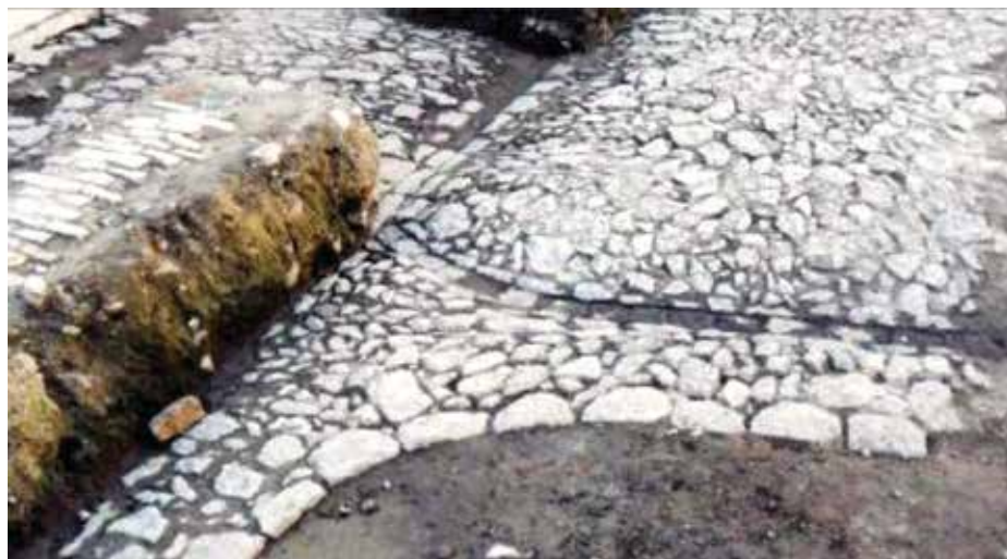
Figura 54. Arremate e drenagem descritos acima.
