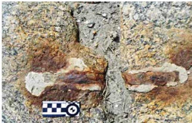
Foto 30 - Mancha em torno dos restos de uma braçadeira de ferro. Arquivo Retrô. Setembro 2014 – p.16
