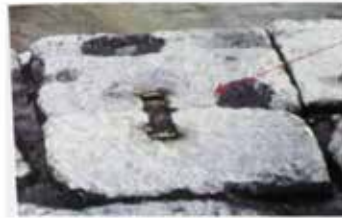
Foto 29 - Grampos ou âncoras usados para fixar as pedras. Fonte: ANDRADE LIMA
