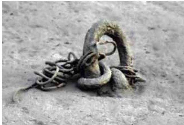
Figura 40. Cabo de amarração encravado na pedra no relatório da Retro utiliza-se a nomenclatura Arganéu.
