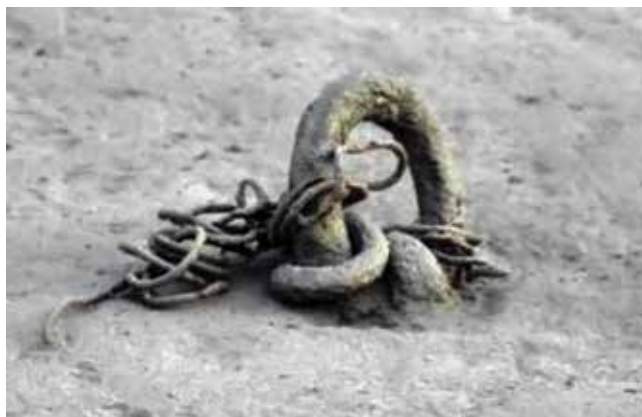
Foto 31 - Anel da amarração incrustado na pedra. Fonte: ANDRADE LIMA, 2013, p. 55
