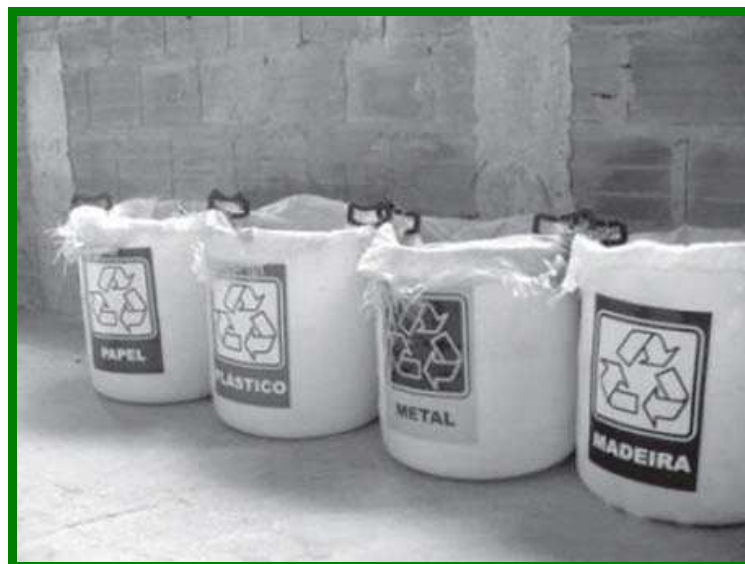
Exemplos de bombonas a serem utilizadas para segregação de resíduos de Classe B
