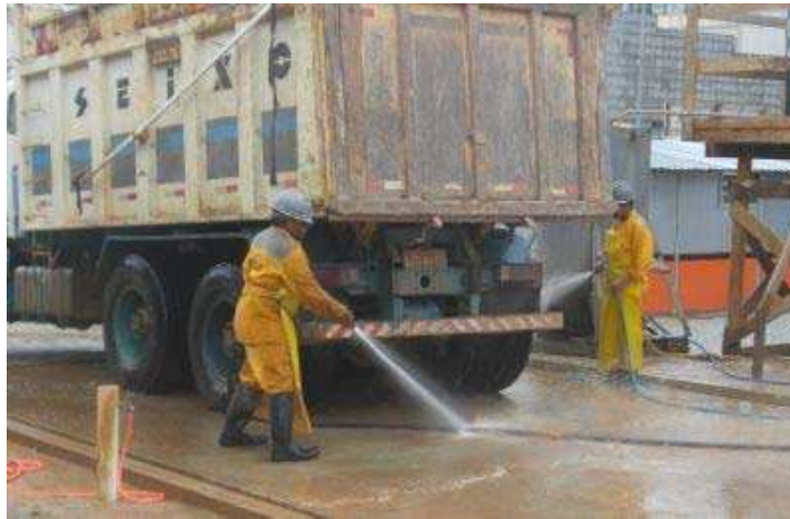
Exemplo de operação de lavagem de pneus em obras
