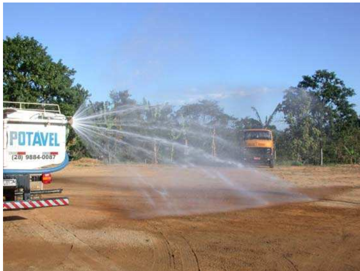
Exemplo de aspersão com utilização de caminhão pipa
