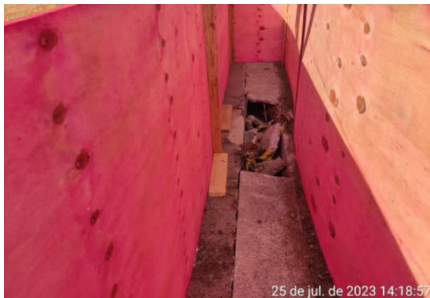
Figura 26 – Grelha quebrada a ser consertada
