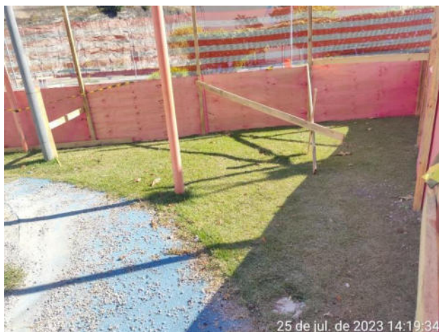
Figura 24 – Junta entre piso e canteiro
