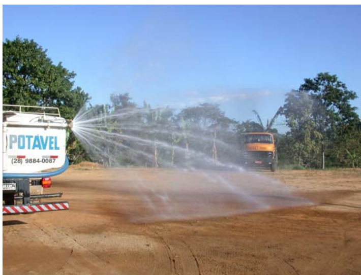
Exemplo de aspersão com utilização de caminhão pipa
