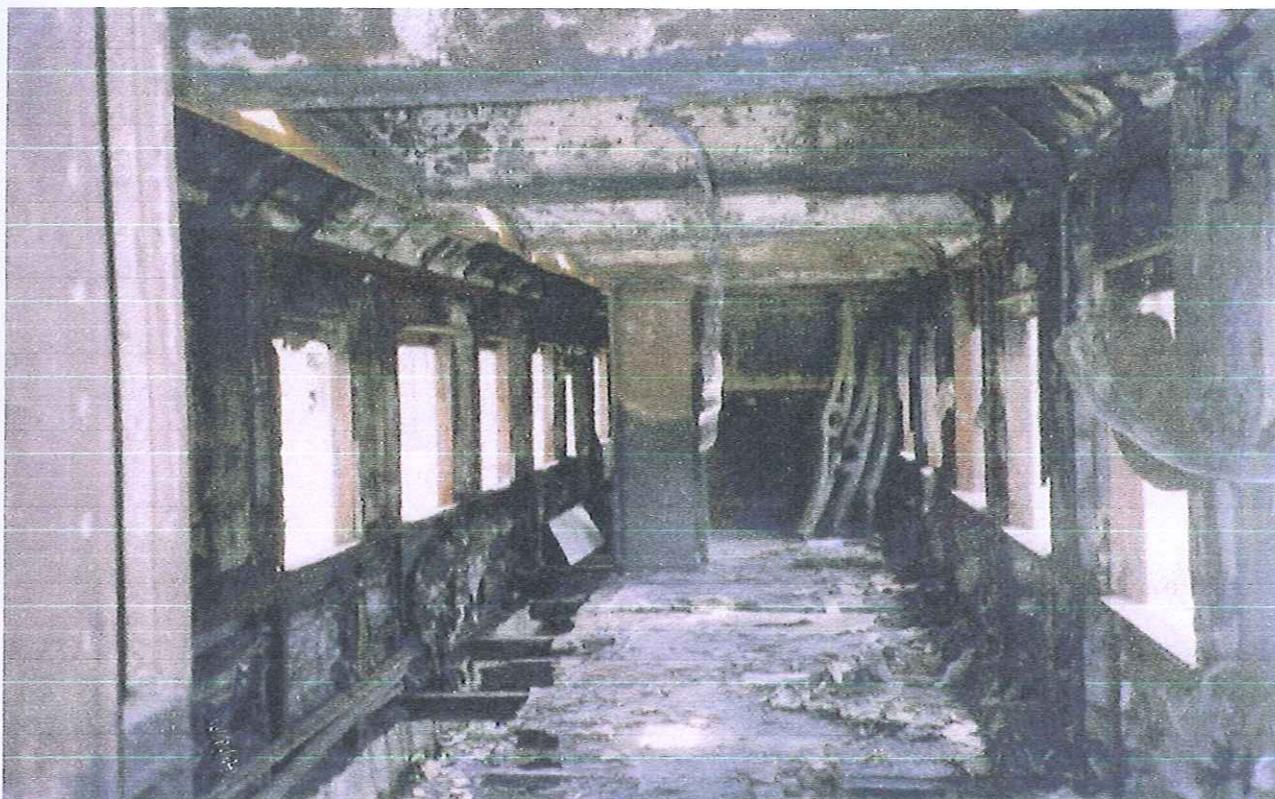
O piso do vagão era em argamassa pigmentada (foto7), cuja composição a análise do material coletado vai determinar, montada sobre tabuleiros de chapa galvanizada que se apoiavam em estrutura de madeira ( foto8 ).
