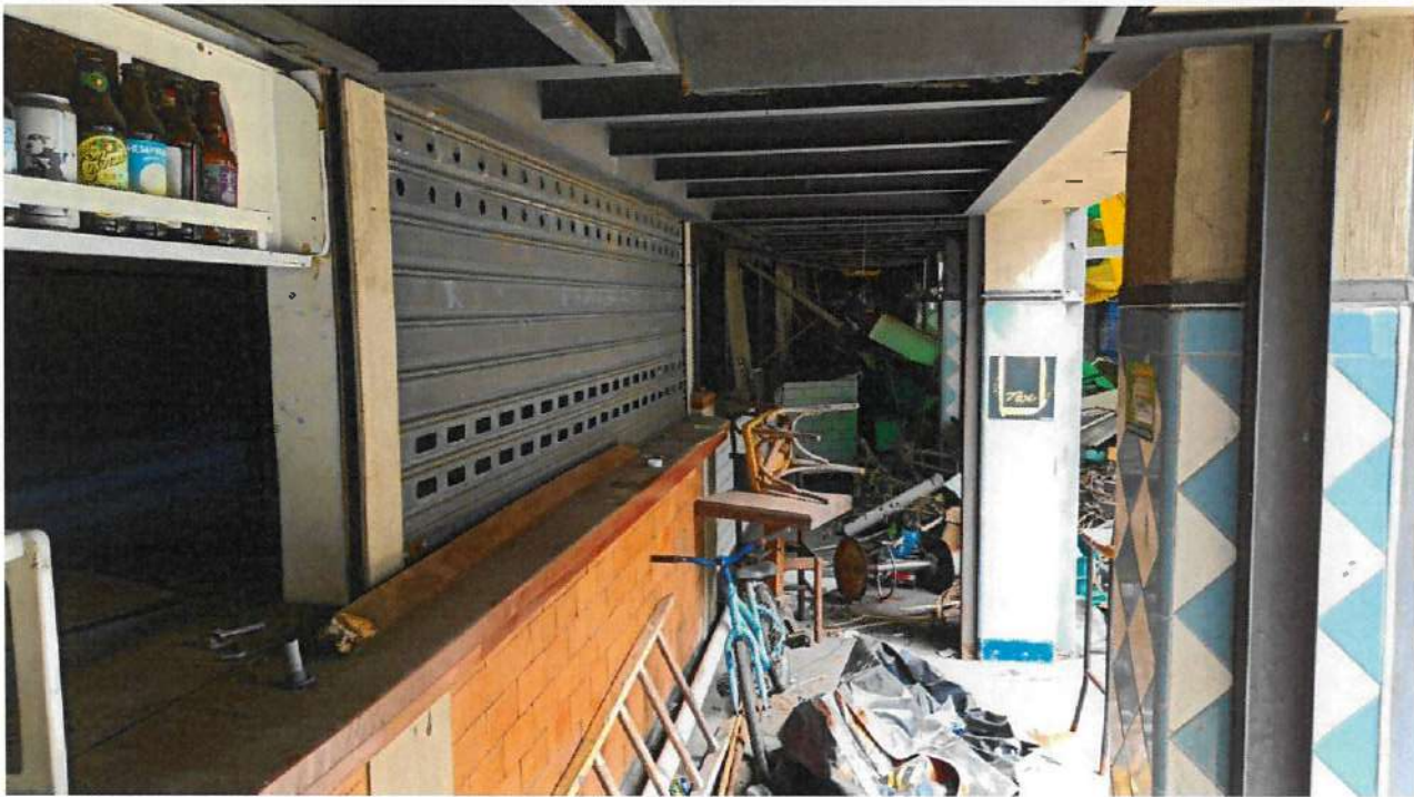
Foto 19: Vista Interna do Imóvel: Corredor da Lateral Direita
