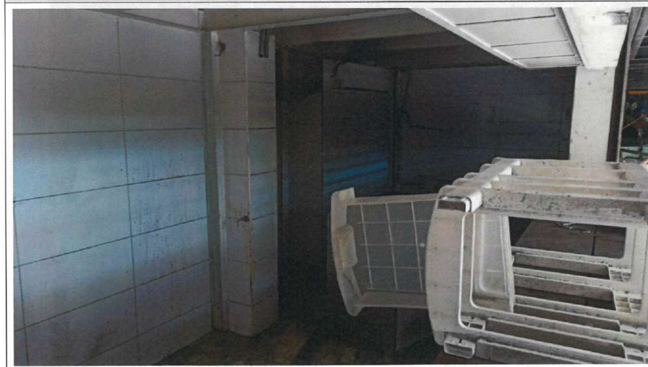
Foto 21: Vista Interna do Imóvel: Boxes 14 e 15
