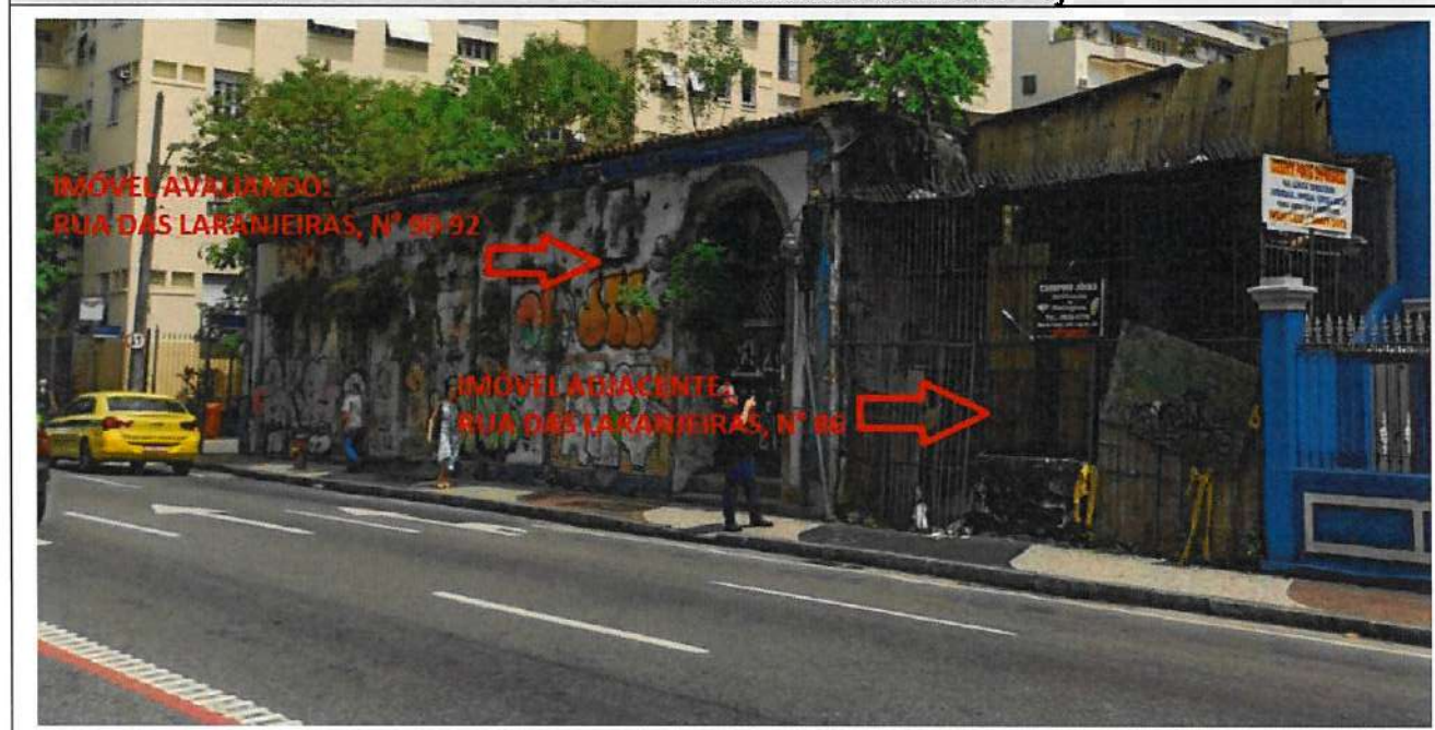
Foto 35: Fachada do Imóvel Avaliando e do Imóvel Adjacente
