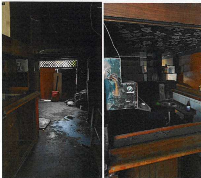
Foto 27: Vista Interna do Imóvel: Boxe -Lateral Esquerda (ao lado do espaço sob o mezanino)
