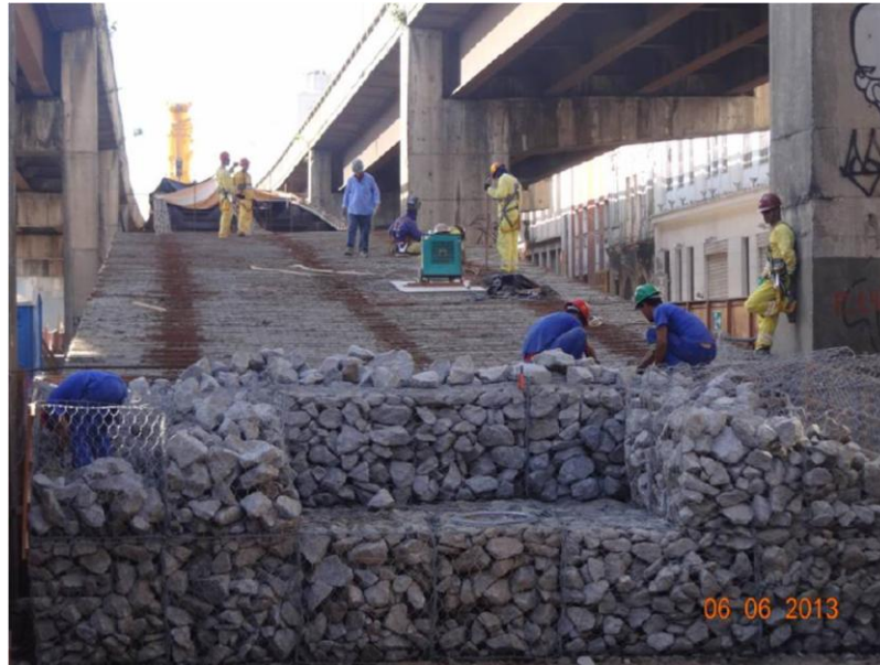
Figura 6.2.2.11 – Rampa de subida para Perimetral sentido Centro – Zona Sul
