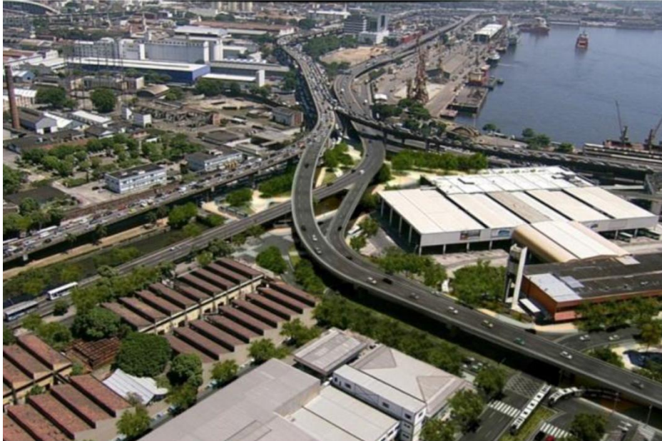
Figura 6.2.2.9 – Desenho dos viadutos de ligação do viaduto do Gasômetro e as vias do Binário - em execução
