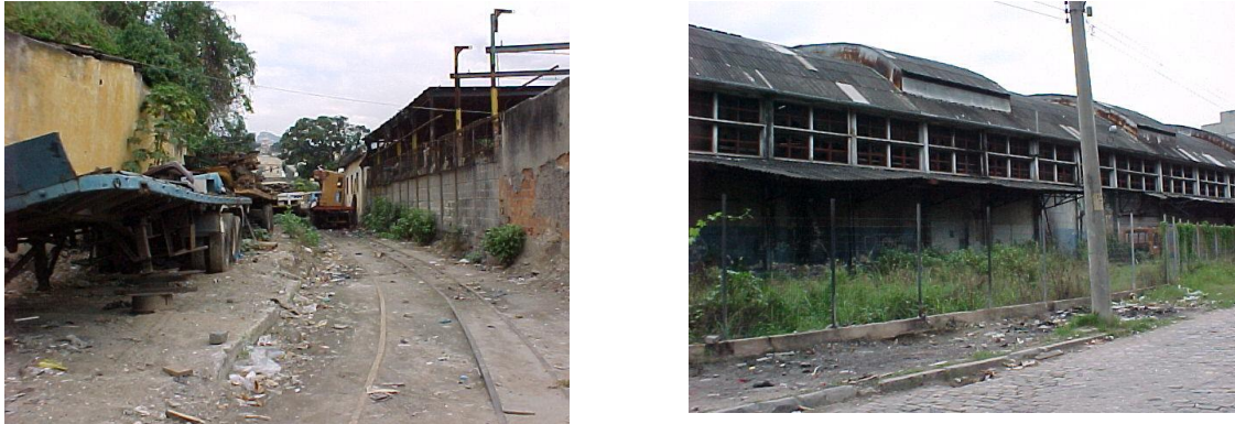
Figura 2.1.2 - Área de Aterro do Porto Novo do Rio de Janeiro (foto recente)
