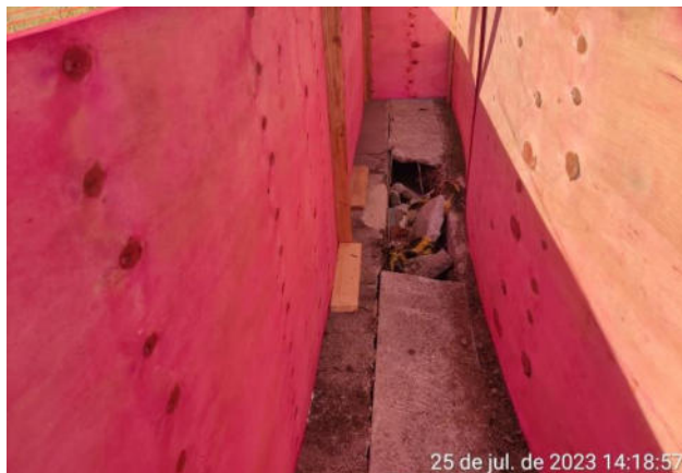
Figura 26 – Grelha quebrada a ser consertada
