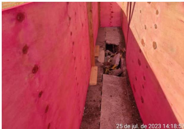
Figura 26 – Grelha quebrada a ser consertada
