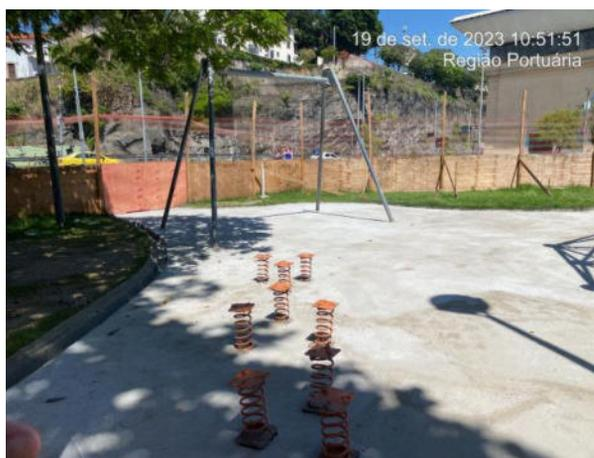
Figura 33 – Piso cimentado e impermeabilizado
