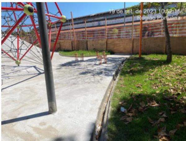
Figura 30 – Piso cimentado e impermeabilizado
