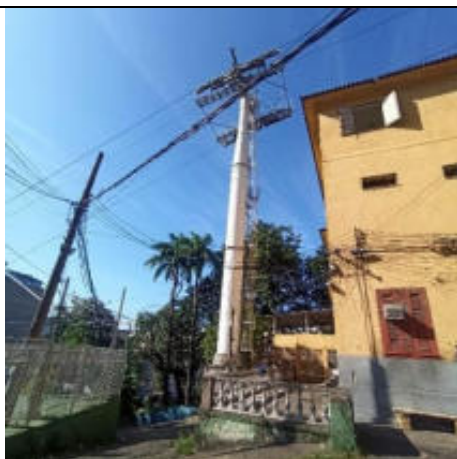
Foto 48 – Vista geral da torre 07.
