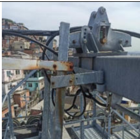
Foto 46 – Conexões do elemento de topo apresentando corrosão.
