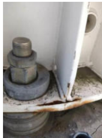
Foto 65 – Restante dos elementos do topo das torres não apresentando anomalias aparentes.
