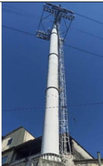
Foto 21 – Vista geral da Torre 03.
