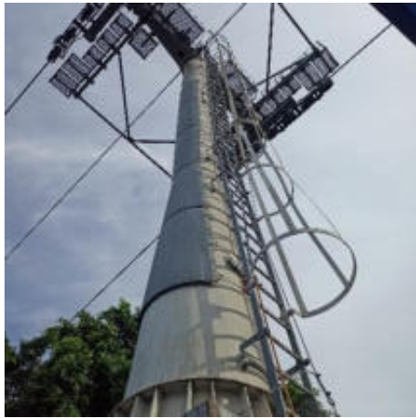
Foto 29 – Vista geral da torre 04.
