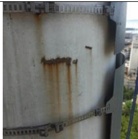
Foto 43 – Regiões com corrosão dos elementos metálicos tubulares.
