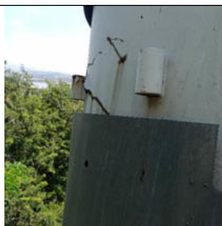
Foto 39 – Foto aproximada do anteparo e conexões da escada das torres.
