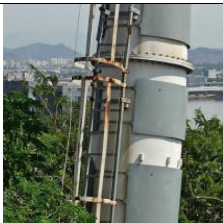
Foto 38 – Anteparo e conexões das escadas apresentando corrosão
