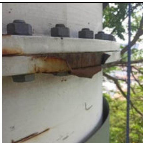
Foto 44 – União entre peças tubulares apresentando corrosão.
