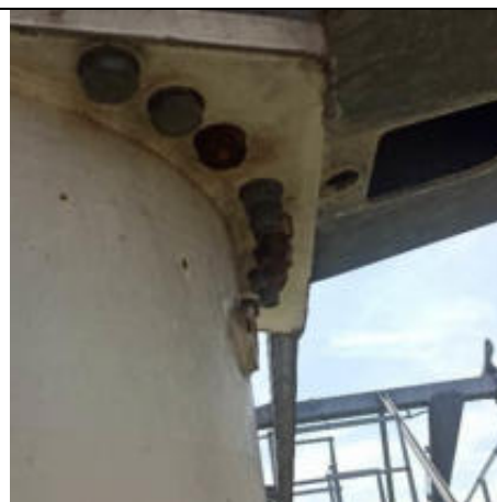
Foto 45 – União entre torre e topo com corrosão nas conexões.
