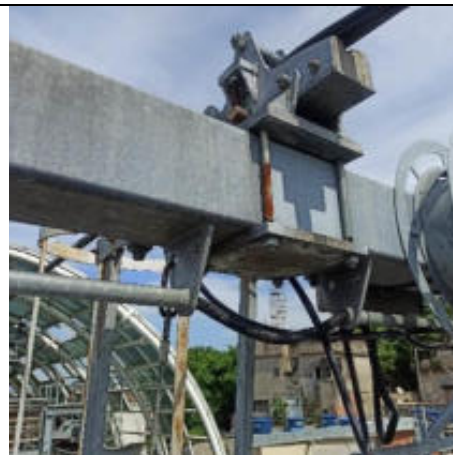
Foto 47 – Conexões do elemento de topo apresentando corrosão.
