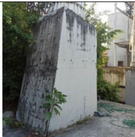
Foto 57 – Restante dos elementos do topo das torres não apresentando anomalias aparentes.
