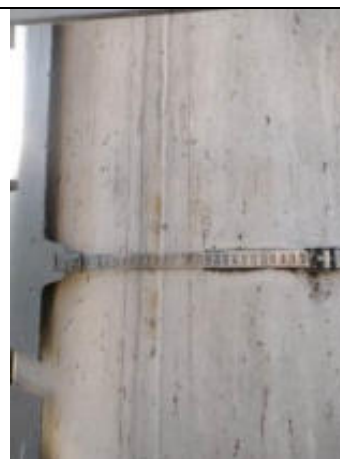
Foto 61 – Restante dos elementos do topo das torres não apresentando anomalias aparentes.
