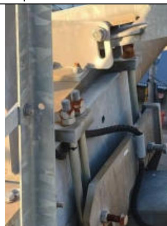
Foto 71 – Restante dos elementos do topo das torres não apresentando anomalias aparentes.
