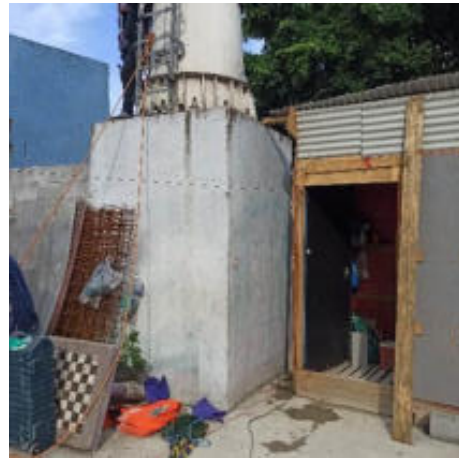
Foto 30 – Base de concreto não apresentando anomalias aparentes.
