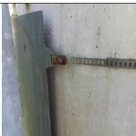
Foto 38 – Anteparo e conexões das escadas apresentando corrosão
