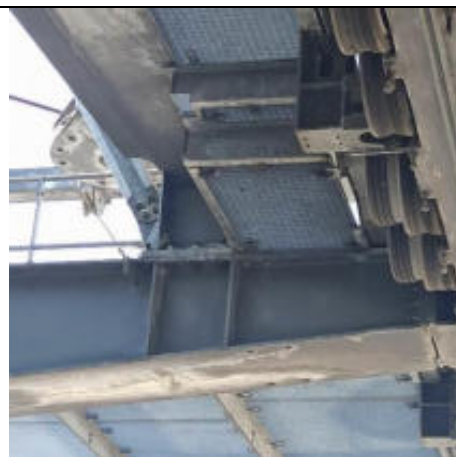
Foto 75 – Conexões corroídas.
