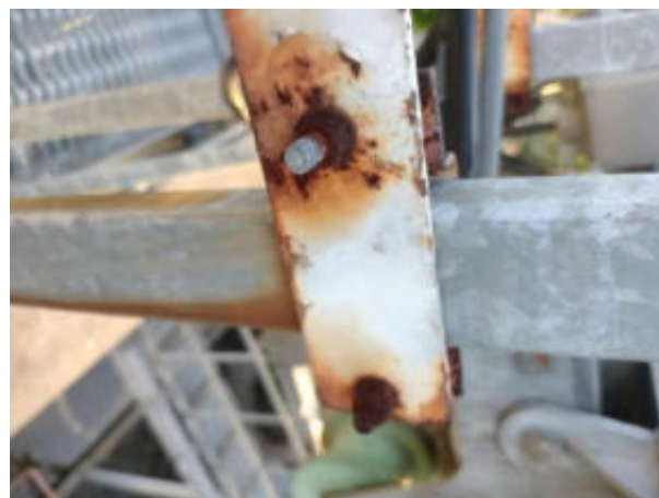
Foto 59 – Restante dos elementos do topo das torres não apresentando anomalias aparentes.
