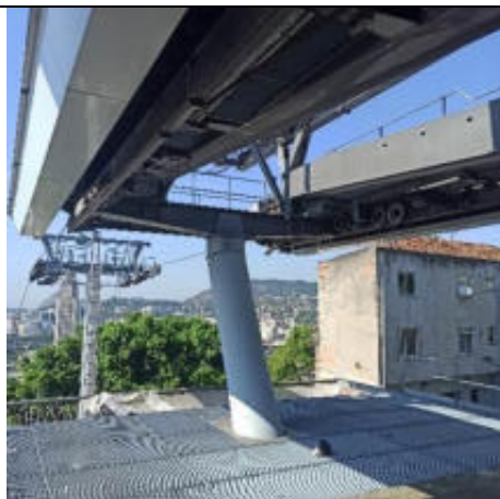
Foto 72 – Vista geral da torre.
