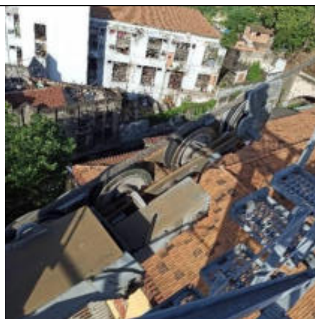
Foto 55 – Restante dos elementos do topo das torres não apresentando anomalias aparentes.
