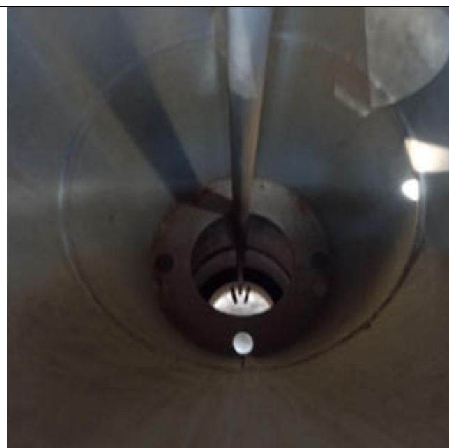
Foto 8 – Interior das torres não apresentaram anomalias aparentes.
