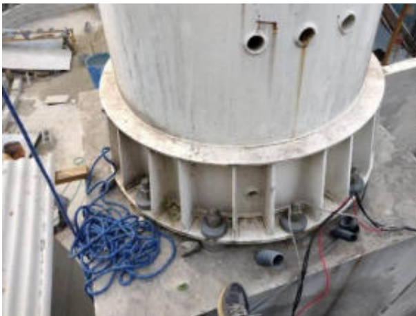
Foto 31 – União entre torre e base de concreto não apresentando sinais de deterioração aparentes.
