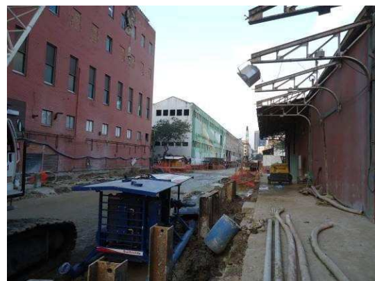
Escavadeira preparando a implantação da mureta guia..
