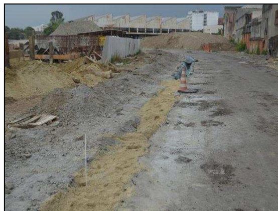
Área/Rua: D 1, Setor D. Valas sendo aterradas após colocação de tubulações de energia, telecomunicações. Orientação: (SUL-NORTE)
