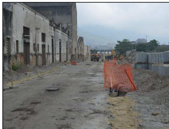
Área/Rua: D 1, Setor D. Abertura de valas para alocação de tubulações. Orientação: (Oeste-Leste)
