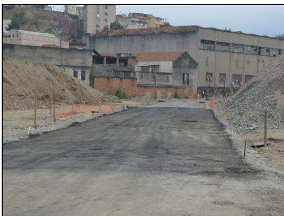
Área/Rua: D 1, Setor D. Valas sendo aterradas após colocação de tubulações de energia, telecomunicações. Orientação: (SUL-NORTE)
