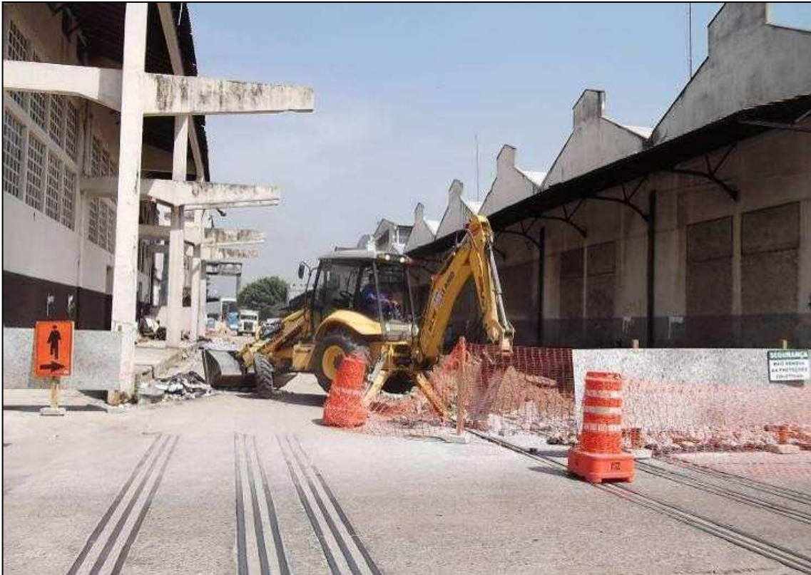
Galpões ao redor da Rua da Gamboa e as duas faixas da linha férrea que percorrem esta rua.
