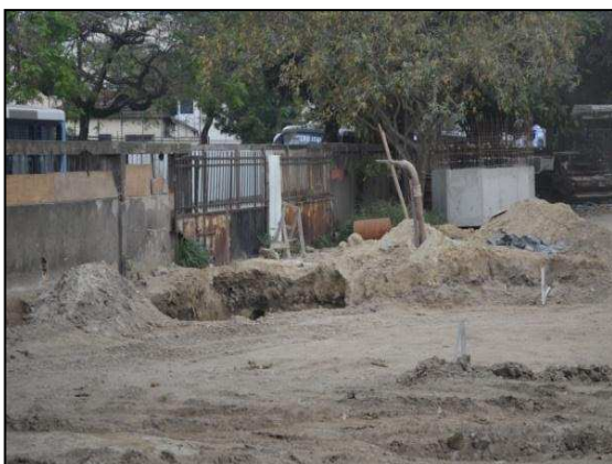
Área/Rua: D 1, Setor D. Valas sendo aterradas após colocação de tubulações de energia, telecomunicações. Orientação: (SUL-NORTE)
