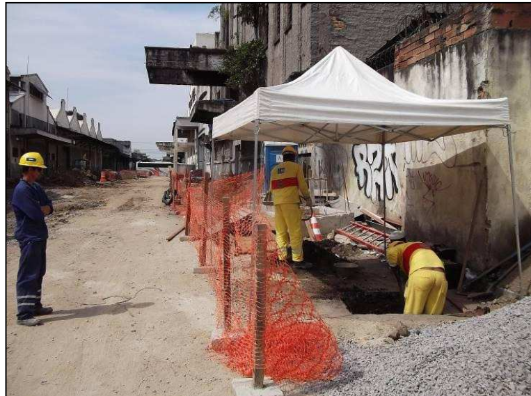
Ambiente e sondagem (Sond.5) sendo aberta na Rua da Gamboa.
