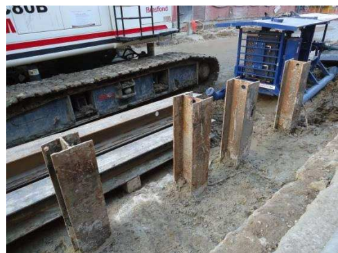
Escavadeira preparando a implantação da mureta guia..
