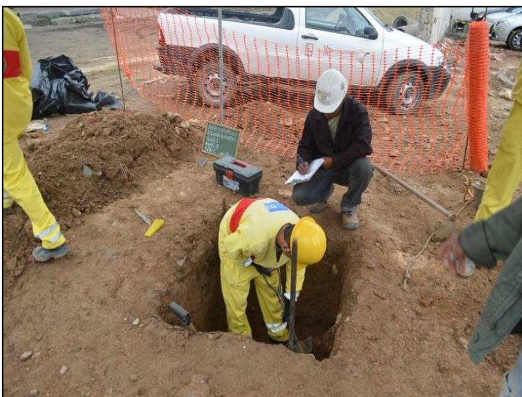
Procedimento inicial de decapagem de 10 em 10 cm, aplicado nas sondagens da Rua da Gamboa e Área Anexa.
