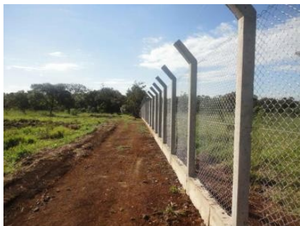
Figura 6 (a+b) - Tipos de cercamento a serem utilizados no aterro (a) Cercamento com moeirão de concreto, (b) Cercamento com coluna em tubo de aço.
