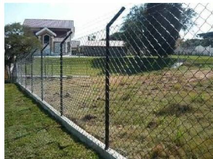
Figura 6 (a+b) - Tipos de cercamento a serem utilizados no aterro (a) Cercamento com moeirão de concreto, (b) Cercamento com coluna em tubo de aço.
