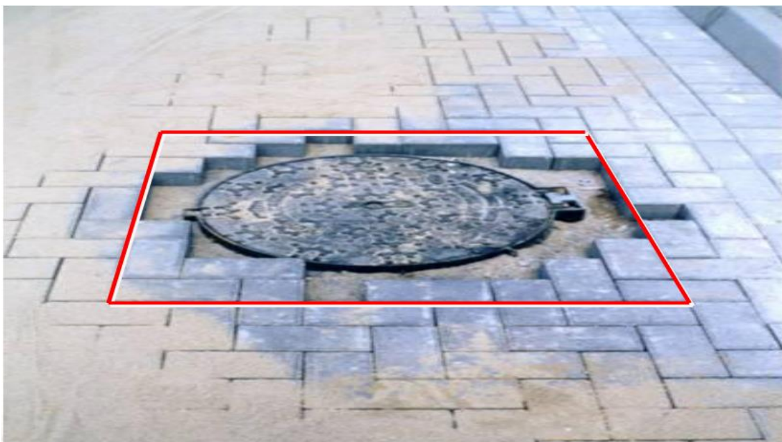
Área que deve ser concretada para o arremate ao redor das tampas circulares.
