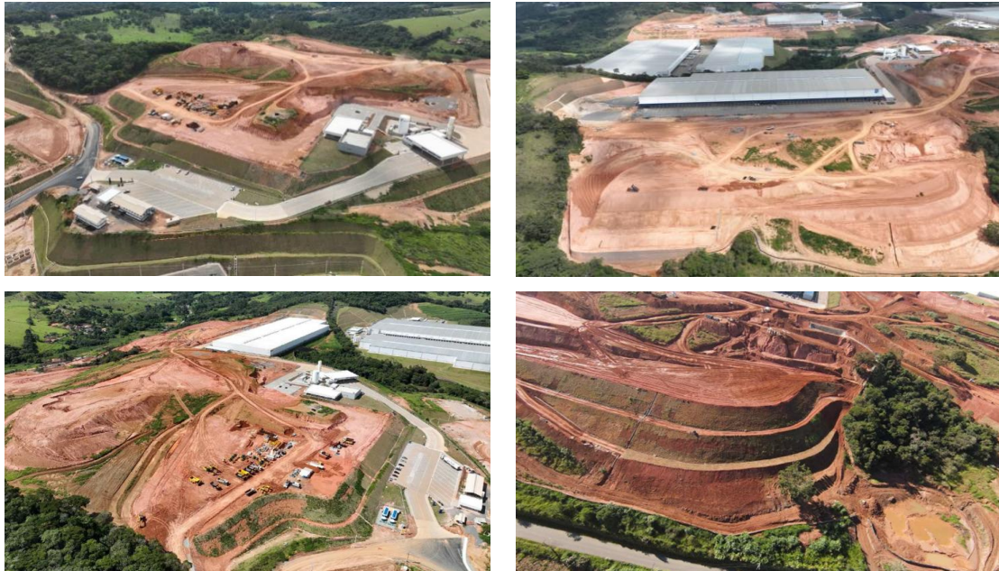
Obras Fase I – Galpão C, Áreas Comuns e Terraplanagem do Galpão D
