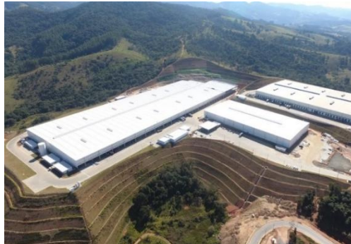
Extrema Business Park – visão aérea
