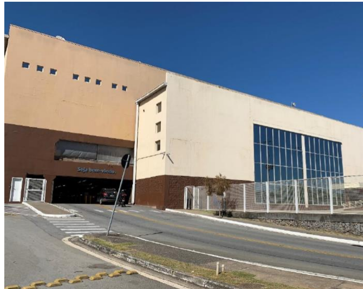
Fonte: Laudo de avaliação realizado pela CBRE, 2019. Esta foto ainda não apresenta o imóvel reformado com a nova marca BIG.
