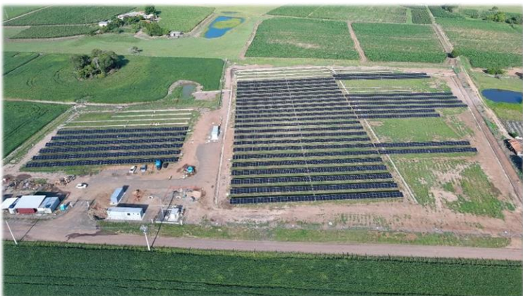
Usina fotovoltaica Venâncio Aires III, no RS.
