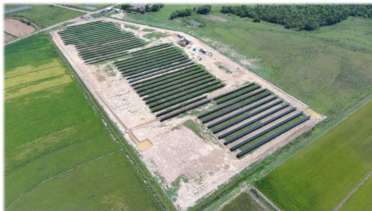
Usina fotovoltaica Santa Cruz do Sul I, no RS.
