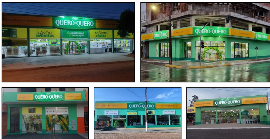
Em sentido horário: (i) Fachada filial de Pelotas - RS; (ii) Fachada filial de Matelândia - PR; (iii) Fachada da filial de Moreira Sales - PR; (iv) Fachada da filial de Deodópolis - MS; e (v) Fachada da filial de Brochier - RS.
