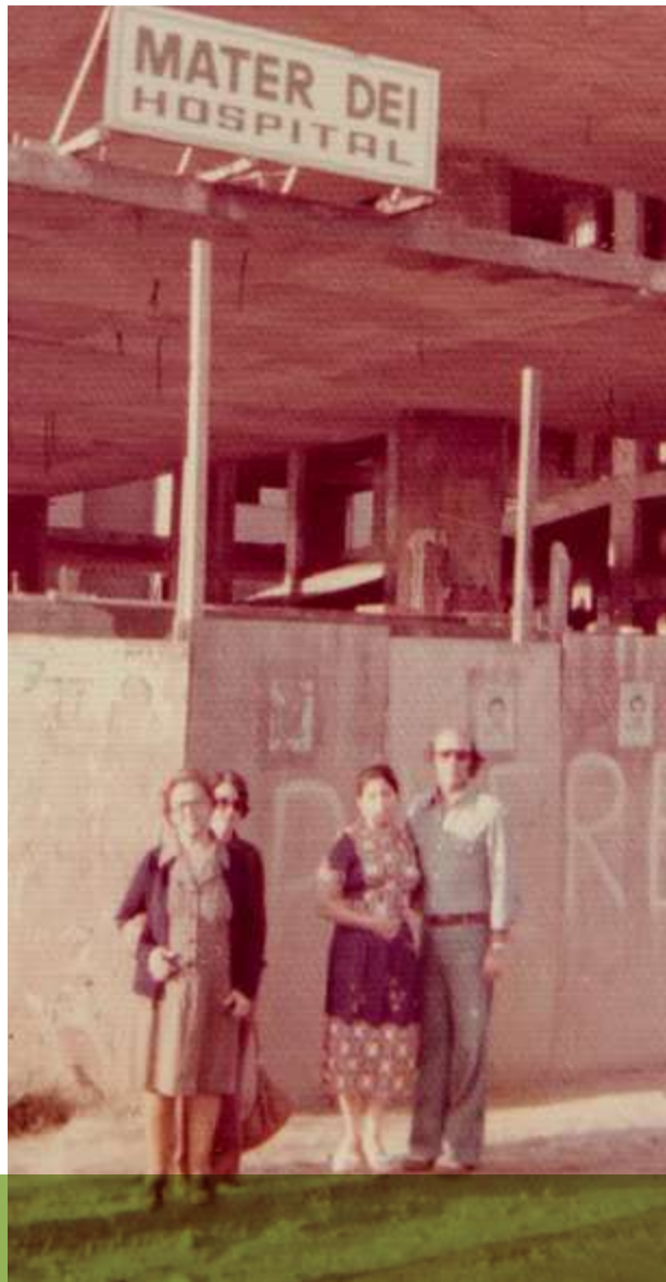
Construção do Mater Dei Santo Agostinho na década de 1970
