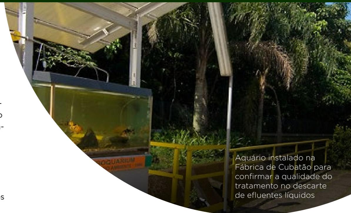
Aquário instalado na Fábrica de Cubatão para confirmar a qualidade do tratamento no descarte de efluentes líquidos
