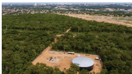
Reservatório Santa Terezinha 4.000m 3 (Cuiabá/MT)
