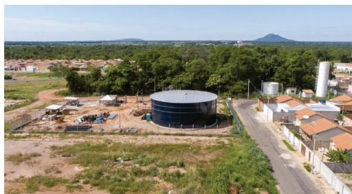
Reservatório Altos do Parque 3.000 m 3 (Cuiabá/MT)
