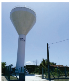
Reservatório Taça 500m 3
