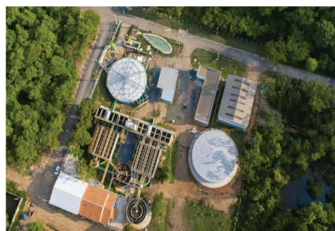
ETA Ribeirão do Lipa 400 l/s (Cuiabá/MT)
