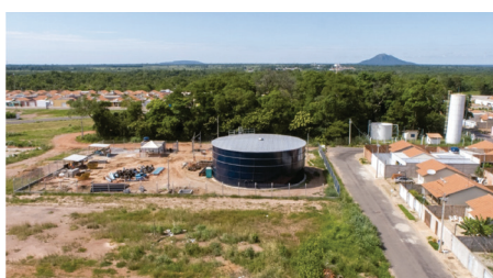
Reservatório Altos do Parque 3.000 m 3 (Cuiabá/MT)
