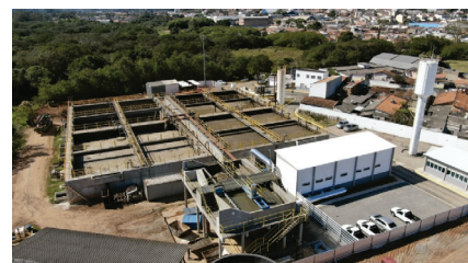
ETE Estoril 200 l/s (Atibaia/SP)
