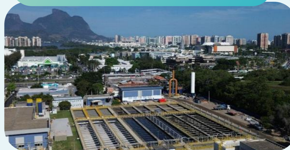
ETE Barra - Iguá Rio
