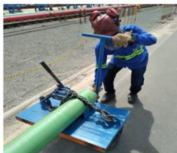
Dispositivo criado para transporte dos tubos com amarração apropriada eliminando o risco de queda dos tubos.
