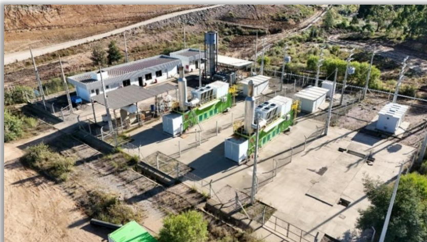
Figura 38 – Projeto Figueira – Impacto Energia
