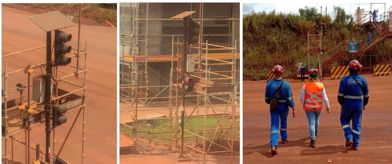
Figura 90, 91 e 92 - Semáforo a Led com placa voltaica na unidade da Vale S11D, em Canaã dos Carajás/PA
