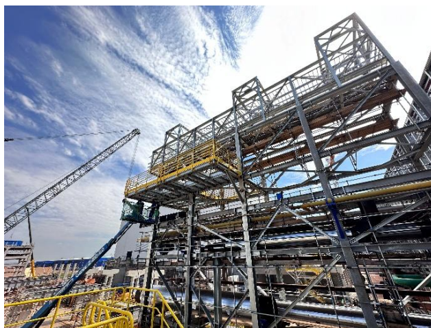
Figura 64 - Obra 115 Vale São Luís
