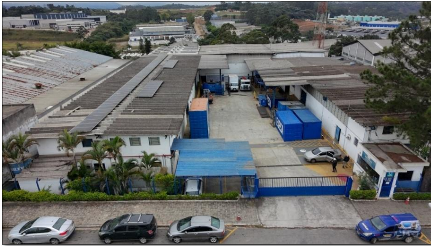
Figura 95 - Placas Fotovoltaicas – Central de Operações – Arujá/SP
