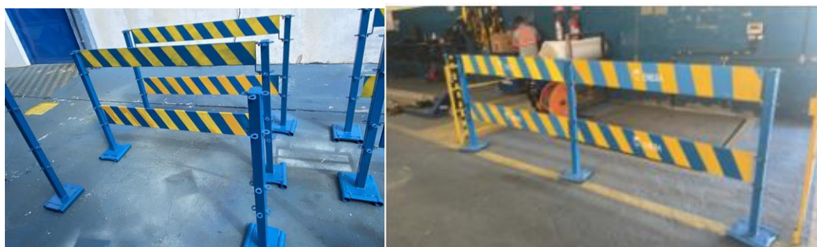
Figuras 103 e 104 – Reaproveitamento de sucata de tampas de eletrocalhas para confecção de barreira física - Obra 008 – Central de Operações Arujá – SP em 2025
