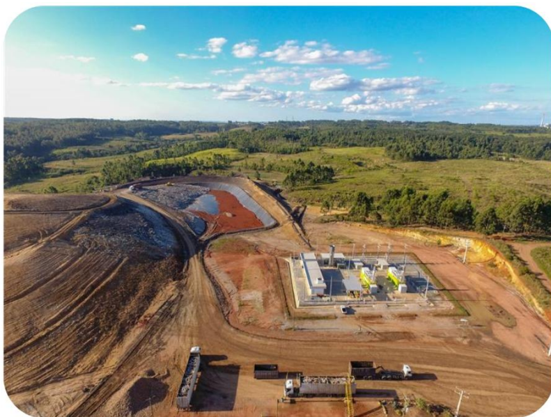
Figura 41 - Projeto Figueira – Impacto Energia
