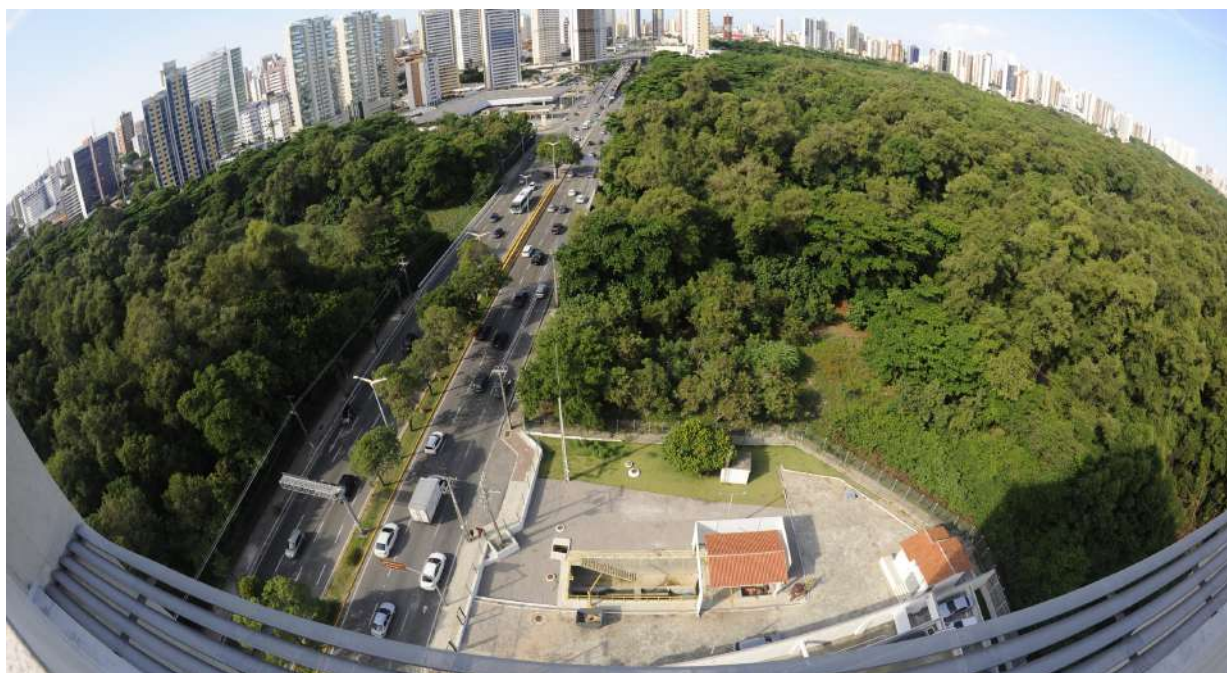
Estação Elevatória de esgoto Parque do Cocó
