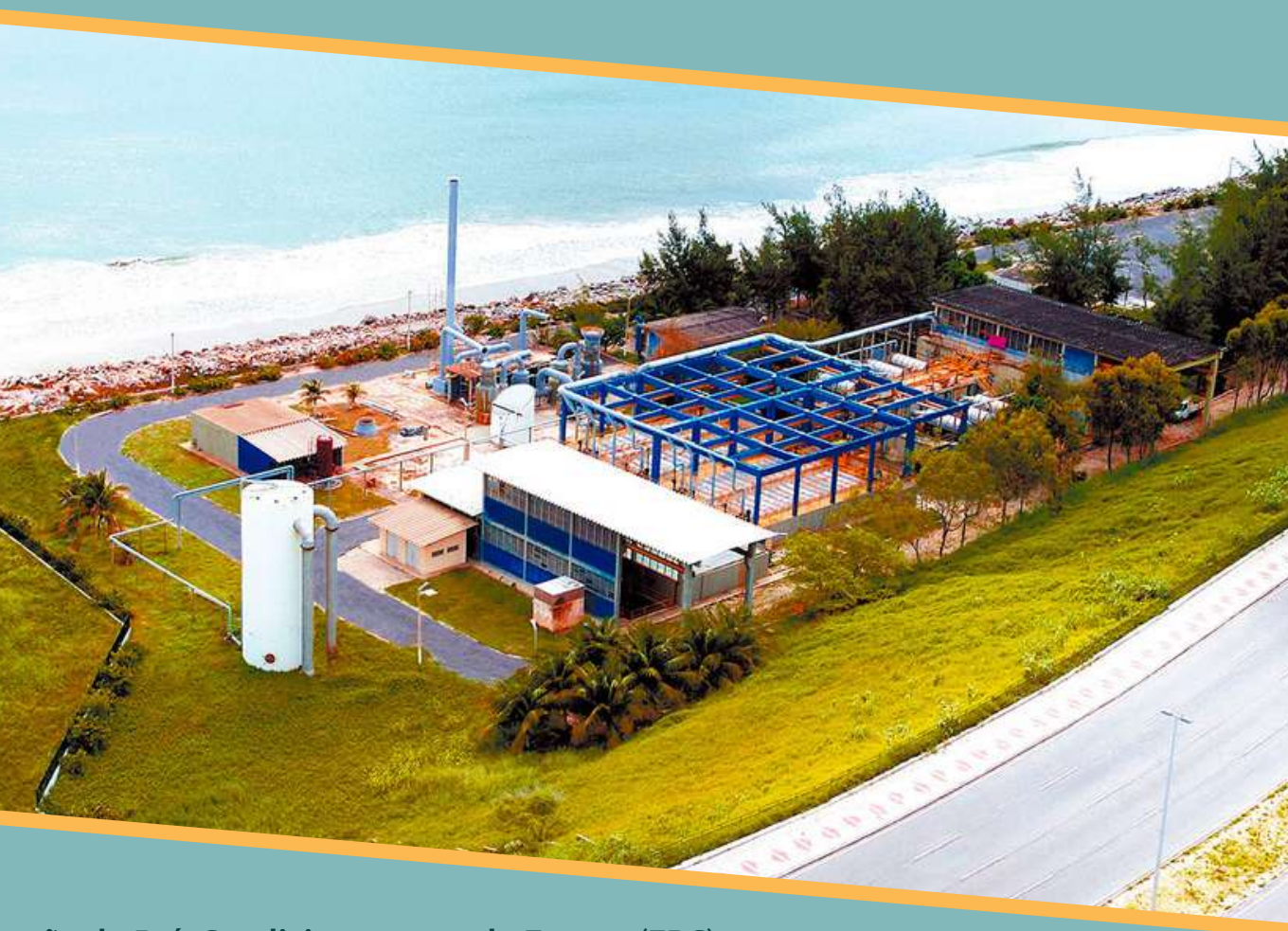
Estação de Pré-Condicionamento de Esgoto (EPC)
