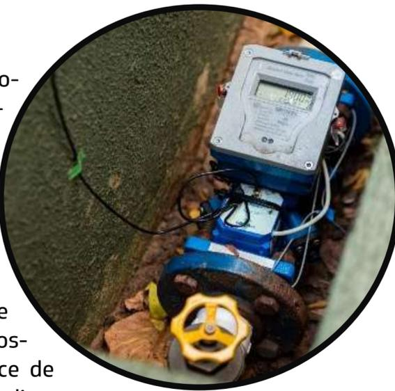
A Cagece vem inovando e modernizando o serviço de medição de consumo de água através da implantação da telemetria para grandes clientes. Essa tecnologia permite a leitura remota e em tempo real dos hidrômetros, eliminando a necessidade de visitas de leituristas e possibilitando a detecção precoce de vazamentos e fraudes. Além disso, os clientes podem acompanhar o consumo através do aplicativo da Companhia, facilitando o controle dos gastos e promovendo o uso consciente da água.
