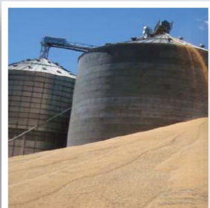
COLAPSO DA INFRAESTRUTURA
