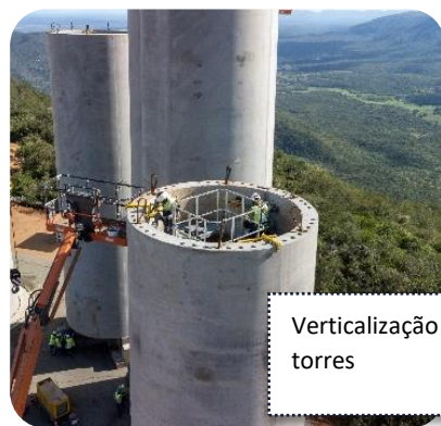
Pré montagem das aduelas finalizadas
