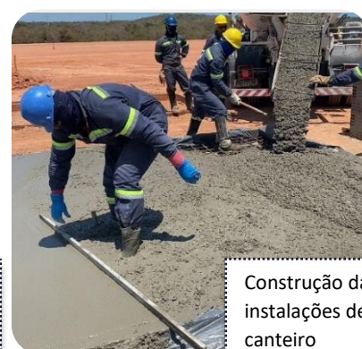
Construção das instalações de canteiro
