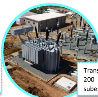
Transformador de 200 MVA da subestação
