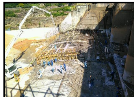
Demolição concluída e construção das novas comportas em andamento
