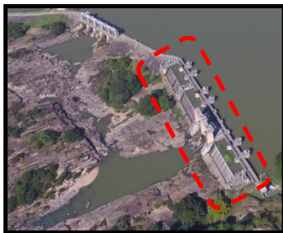
Vista aérea das 03 comportas que serão substituídas
