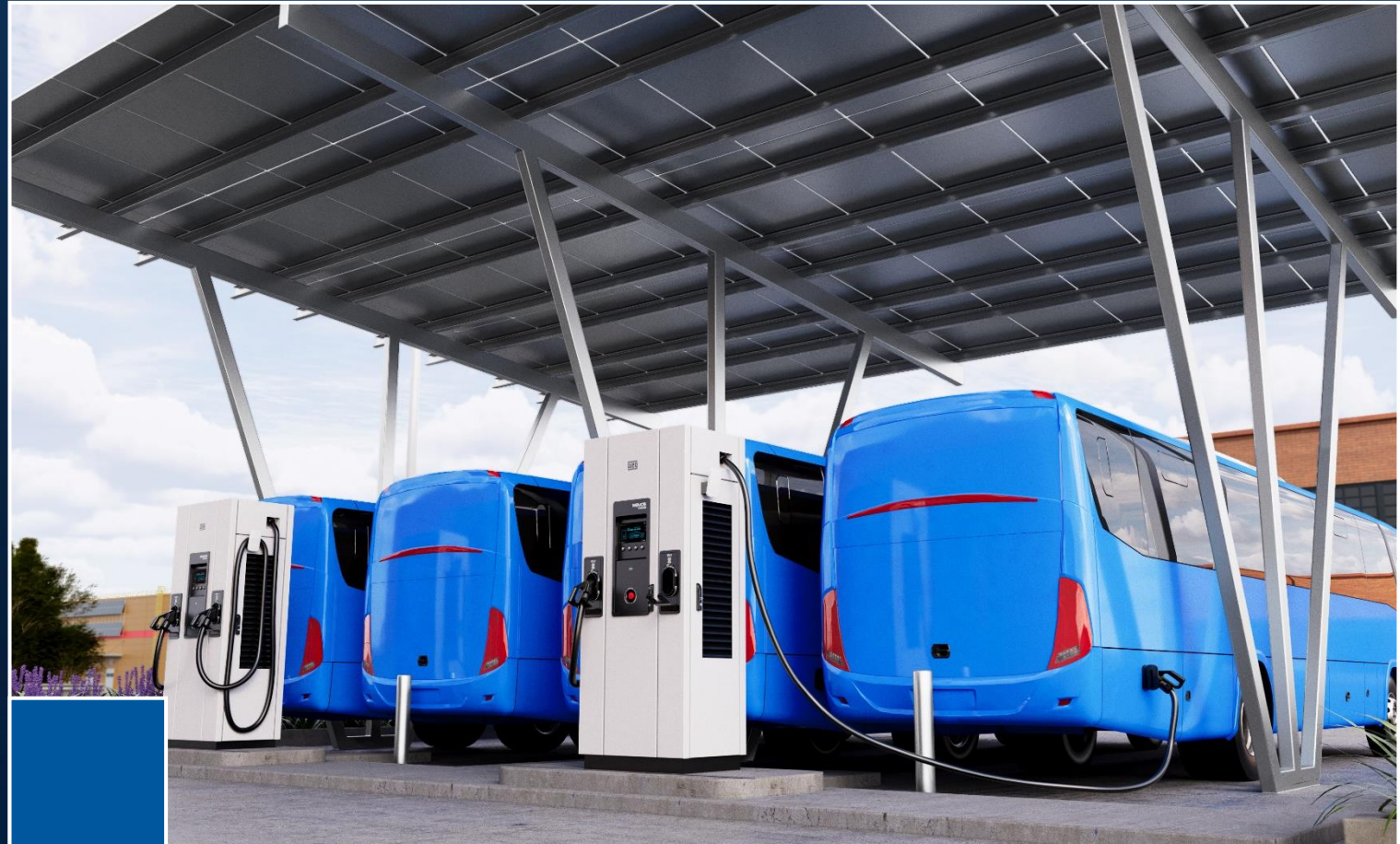
Garagens e centro de distribuição
