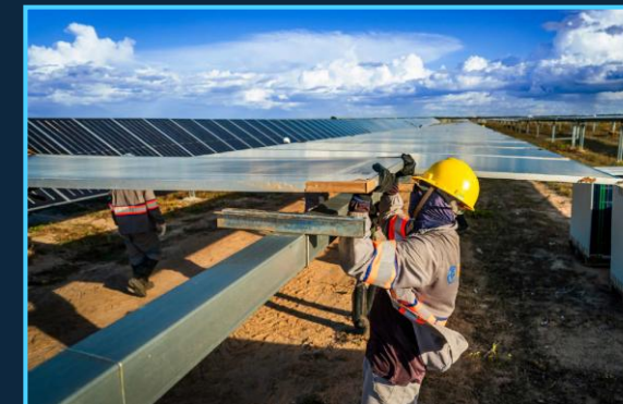
INSTALAÇÃO ELETROMEQUÂNICA E CIVIL
