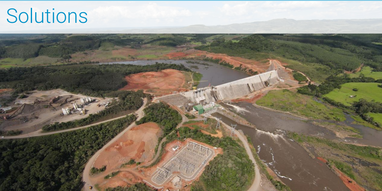
UHE São Roque – Generator 50 MW
