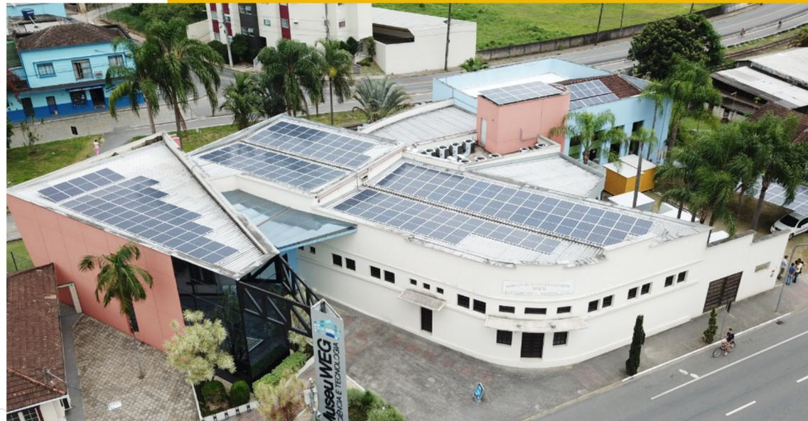
O MUSEU CONTOU COM A INSTALAÇÃO DE ENERGIA SOLAR FOTOVOLTAICA. O SISTEMA PRODUZ 74.310,69 KWH/ANO E SUPRE 70% DA ENERGIA ELÉTRICA CONSUMIDA PELO PRÉDIO.
