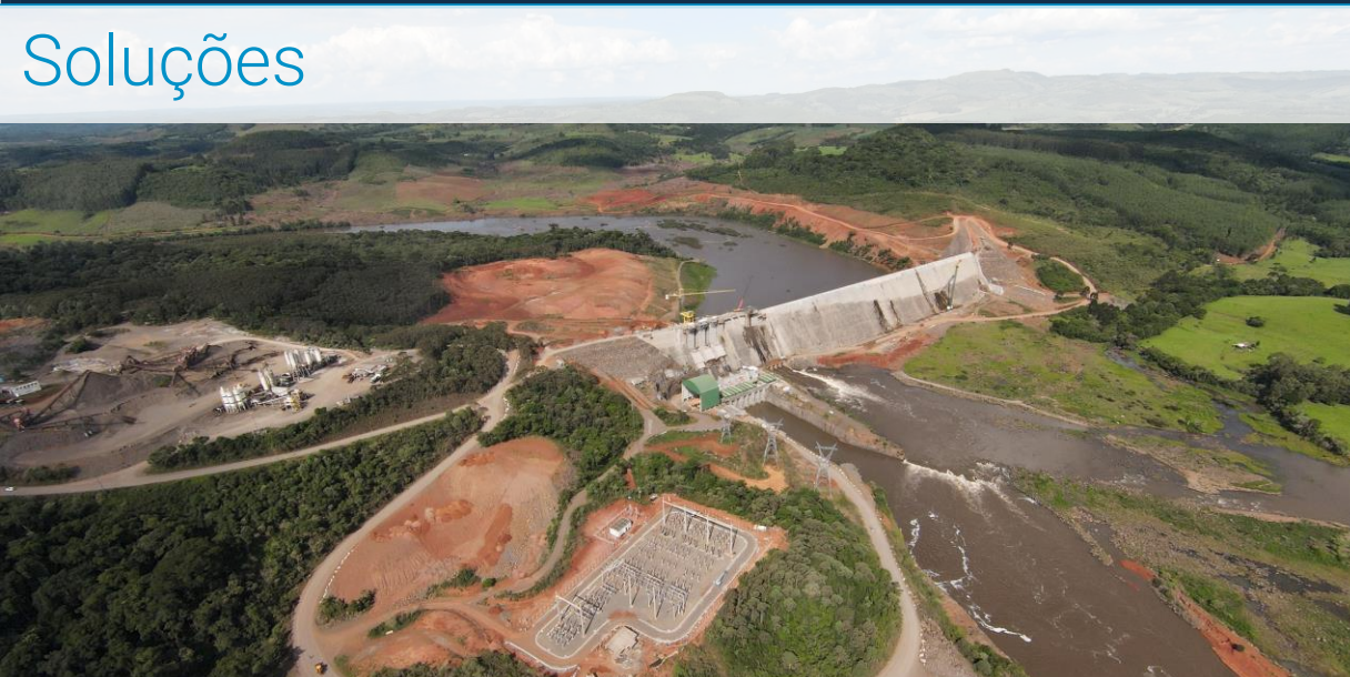
UHE São Roque – Gerador 50 MW
