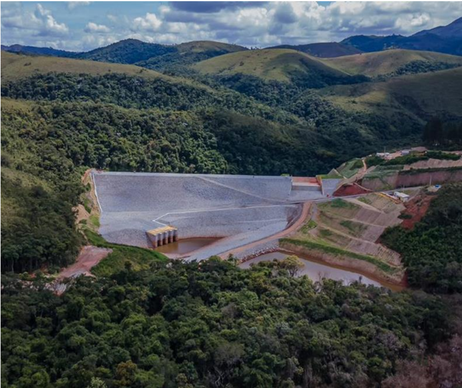
Estrutura de contenção da barragem B3/B4, concluída no 4T20
